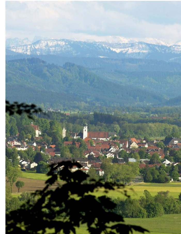
Unser Feldtestgebiet: Umspannwerk Leutkirch. Das Versorgungsgebiet erstreckt sich über die große Kreisstadt Leutkirch, inklusiver der östlich angrenzenden bayrischen Ortsteile Fraunzell, Muthmanshofen, Schreiloch, Kimmratshofen.
