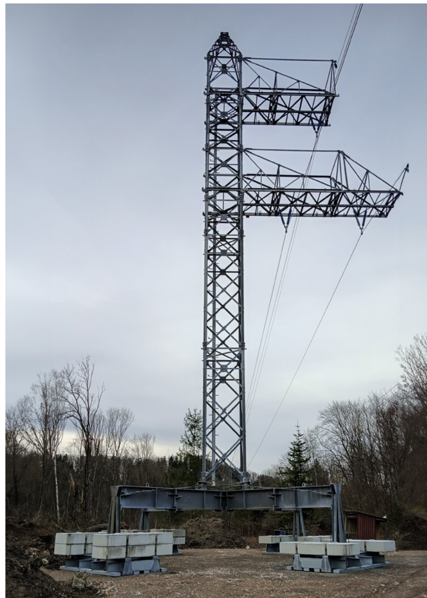
Provisorischer Freileitungsmast, der nach einem Trassenausfall zur Wiederversorgung ausgefallener 110-kV-Stromkreise aufgebaut werden kann. Mithilfe solcher provisorischen Freileitungsmasten können Störungen im Hochspannungsnetz für einen bestimmten Zeitraum behoben werden.
