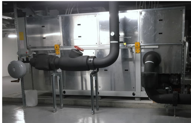
Große Seewasser-Wärmepumpe (Quelle: Siemens)
