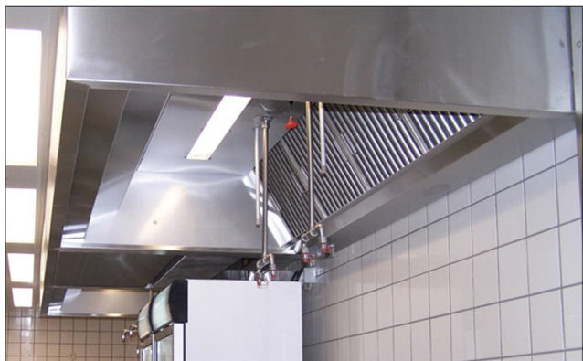
Fig. 6-15 Metallfilter (zwei mögliche Bauformen) und eingebaut in einer Ablufthaube über Kochstelle (Quelle: Reven)
