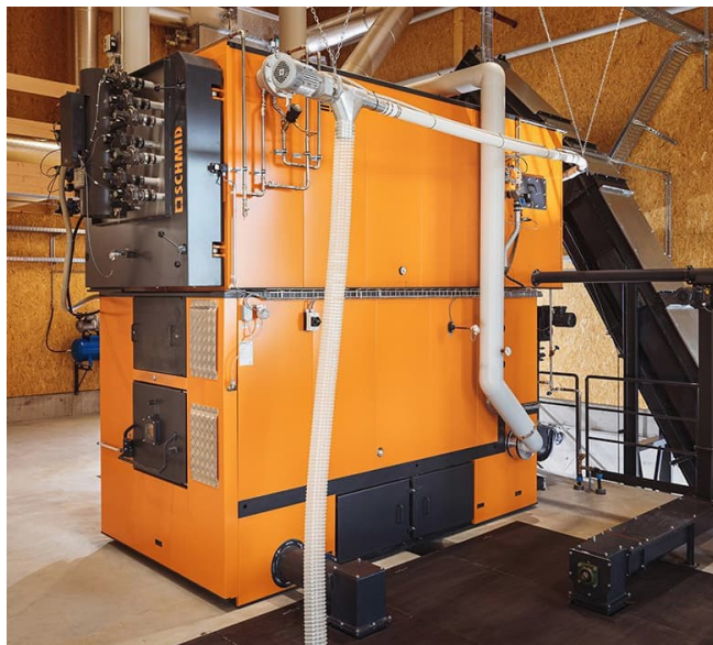
Fig. 3-15 Holzsnitzel-Heizkessel, Holzsnitzel-Produktion im Wald und -Lagerbunker (Quelle: Energieverbund Eschenbach)
