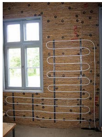
Verlegte Wandheizung an Außenwand (Quelle: Wikipedia)
