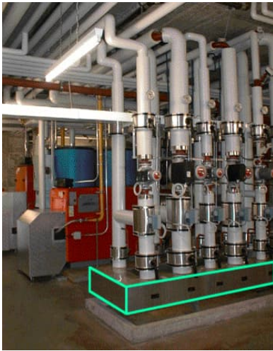
Fig. 5-11 Verteiler als Bindeglied zwischen Erzeuger- und Verbraucherseite
