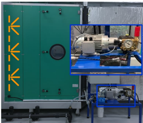
Fig. 6-50 Hochdruck-Verdunstungsbefeuchter mit Sprühdüsen (orange) und Hochdruckpumpe (blau)
