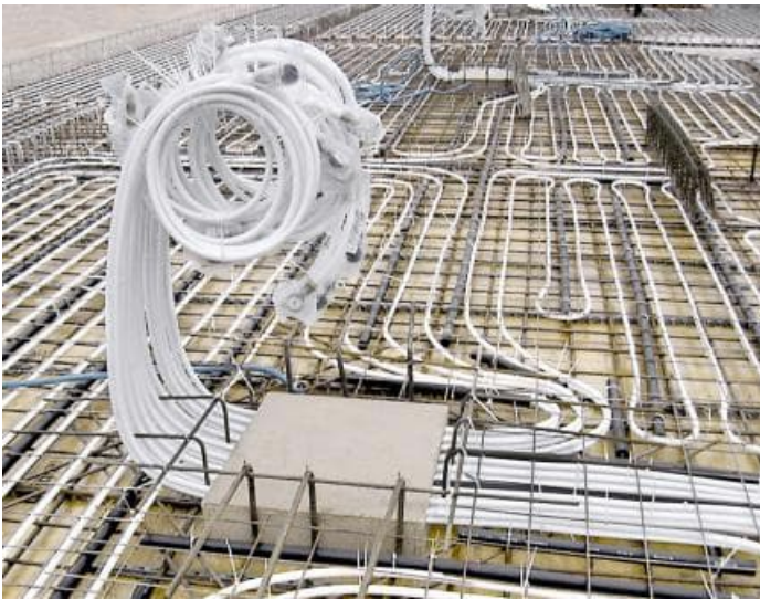
Fig. 3-80 Eingelegte Rohrleitungen in der Geschoßdecke (Quelle Tabs)
