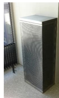
Quellluftauslass Beispiel (Quelle: Durrer Technik)
