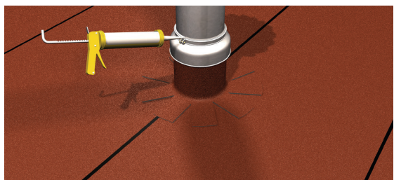
Aplicación de un sombrero. Sellado del mismo con masilla.
