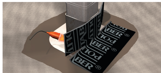
Aplicación de pieza de refuerzo inferior.
