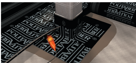
Aplicación de la membrana impermeabilizante.
