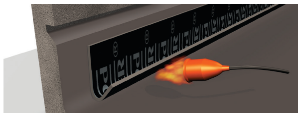
Roza imprimada. Aplicar banda de refuerzo.
