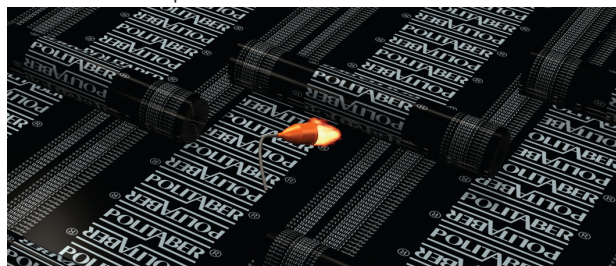
Segunda capa de láminas. Soldada a la anterior.
