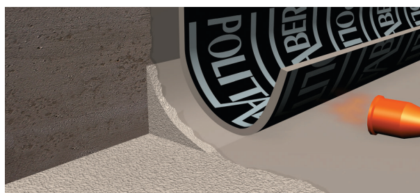
Aplicación de la banda de refuerzo.
