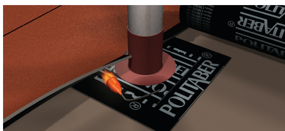
Aplicación de la membrana impermeabilizante.
