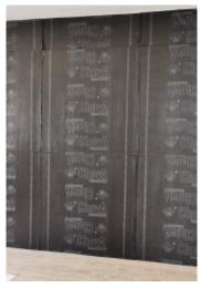
5- Fijar la lámina **ViscoLAM 65** a la placa de yeso laminado. Los diferentes tramos de lámina se colocarán a testa y contrapeando las juntas de la placa de yeso laminado.
