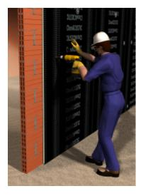
2- Realizar los agujeros sobre el material con un taladro y una broca de 8 mm, en las posiciones que se indican en el esquema. La profundidad deberá ser de al menos 4 cm. Introducir las espigas de fijación **ChovAFIX 6** con la ayuda de un martillo, quedando distribuidas 5 espigas por metro cuadrado.
