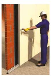
6- Atornillar las placas de yeso laminado de 15 mm a la estructura metálica y encintar las juntas entre ellas siguiendo las instrucciones de montaje de los sistemas de placa de yeso laminado.
