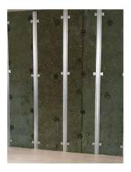
3- Atornillar el amortiguador FTD OMEGA al tabique existente sobre el ChovACUS-TIC PLUS FIELTEX. Fijar la perfilería 'omega' con un clic al amortiguador. La distancia de modulación será de 600mm
