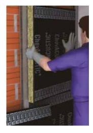
2- Comenzar a colocar los paneles entre los montantes, en dirección ascendente y de forma que quede vista la lámina viscoelástica.
