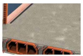
1- Previamente a la instalación del sistema se habrá comprobado que la superficie está limpia, seca y libre de irregularidades. A continuación, colocar en todos los encuentros del forjado con los elementos verticales (pilares y tabiques) la banda perimetral ChovAIMPACT BANDA. Para facilitar la instalación, utilizar la cinta adhesiva ELASTOBAND 50.
