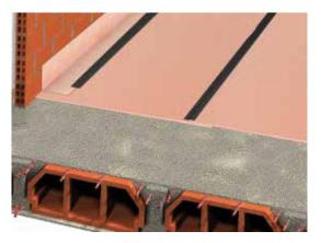
3- En los encuentros con tabiques y pilares instalar el material ChovAIMPACT BANDA para evitar la unión rígida entre solera y paramentos. Para facilitar la instalación utilizar la cinta adhesiva ChovAIM-PACT BANDA DE SOLAPE RT.
