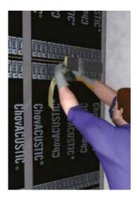
4- A continuación deben sellarse las juntas utilizando la cinta adhesiva **ELASTO-BAND 50**. Para su aplicación, retirar el plástico protector del adhesivo, colocar sobre el panel y presionar ligeramente.
