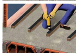
3- Distribuir los rastreles sobre la superficie. La distancia de separación entre sí será de 600 mm. Fijar mediante taco y tirafondo al forjado empleando una fijación cada 900 mm.
