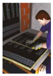
3- Los siguientes paneles se colocarán a testa repitiendo el procedimiento anterior, hasta cubrir por completo la superficie del sistema. Para ajustar los paneles en aquellos huecos que sean de menores dimensiones, se realizará un corte mediante cúter.
