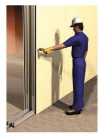
5- Atornillar la segunda capa de placas de yeso laminado de 13 mm a la estructura metálica y sellar las juntas entre ellas siguiendo las instrucciones de montaje de los sistemas de placa de yeso laminado. Las placas se colocan contrapeando las juntas de la lámina **ViscoLAM**.
