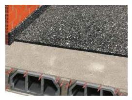
2- Cubrir toda la superficie por completo con los paneles 2 x **ChovAPREN 110/3.** Los paneles se colocan a testa y no es necesario sellar las juntas.
