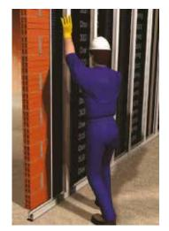
4- Montar la estructura metálica del trasdosado autoportante separada unos 2 cm del material ChovACUSTIC 65 FIELTEX, siguiendo las instrucciones de montaje de los sistemas de placa de yeso laminado. La modulación es de 600 mm entre montantes y se coloca una banda de aislamiento estructural ELASTOBAND 50 autoadhesiva debajo de todos los canales.
