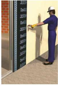
5- Atornillar la segunda capa de placas de yeso laminado de 13 mm a la estructura metálica y sellar las juntas entre ellas siguiendo las instrucciones de montaje de los sistemas de placa de yeso laminado. Las placas se colocan contrapeando las juntas de la lámina ViscoLAM.
