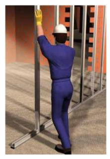
1- Montar la estructura metálica del tabique siguiendo las instrucciones de montaje de los sistemas de placa de yeso laminado. La modulación debe ser de 600 mm entre montantes.
