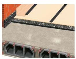
5- En los encuentros con tabiques y pilares instalar el material ChovAIM-PACT BANDA para evitar que los paneles absorban el agua o humedad del mortero. Para facilitar la instalación utilizar la cinta adhesiva ELAS-TOBAND 50.
