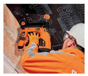
2- Realizar la fijación con la clavadora a gas multi-material PULSA 40 (SPIT). Con clavos C6 40FH de alto rendimiento y arandela ISOWOOD PLANA.
