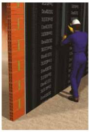
3- El siguiente tramo hay que colocarlo siguiendo las mismas recomendaciones que en los puntos 1 y 2, realizando el solape de 2 cm que presenta el producto. Después, éstas juntas se sellarán con la cinta adhesiva de sellado **ELASTOBAND 50**.
