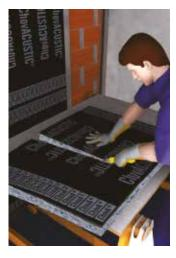
3- Los siguientes paneles se colocarán a testa repitiendo el procedimiento anterior, hasta cubrir por completo la superficie del sistema. Para ajustar los paneles en aquellos huecos que sean de menores dimensiones, se realizará un corte mediante cúter.
