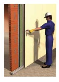
5- Atornillar la segunda capa de placas de yeso laminado de 13 mm a la estructura metálica y sellar las juntas entre ellas siguiendo las instrucciones de montaje de los sistemas de placa de yeso laminado. Las placas se colocarán contrapeando las juntas de la lámina ViscoLAM 65.
