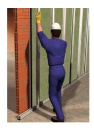
2- Montar la estructura metálica del trasdosado autoportante separada unos 2 cm del material ChovACUSTIC PLUS FIELTEX, siguiendo las instrucciones de montaje de los sistemas de placa de yeso laminado. La modulación será de 600 mm entre montantes y se colocará una banda de aislamiento estructural ELASTOBAND 50 autoadhesiva debajo de todos los canales. Para los trasdosados que deban ser arriostrados se utilizarán los amortiguadores 3801/TD1.
