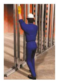
1- Montar las estructuras metálicas del tabique siguiendo las instrucciones de montaje de los sistemas de placa de yeso laminado. La modulación debe ser de 600 mm entre montantes.
