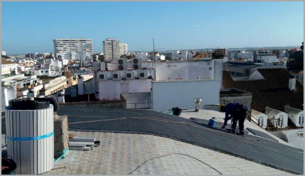
REHABILITACIÓN CON ChovATERM XPS. HUELVA
