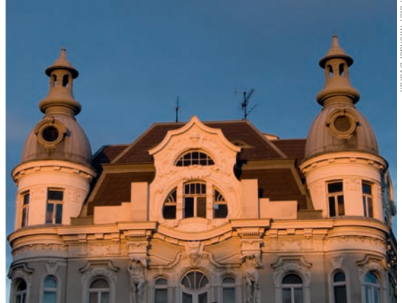
Im Haus am Mariahilfer Gürtel 2 befindet sich eine Mauersegler-Kolonie.
