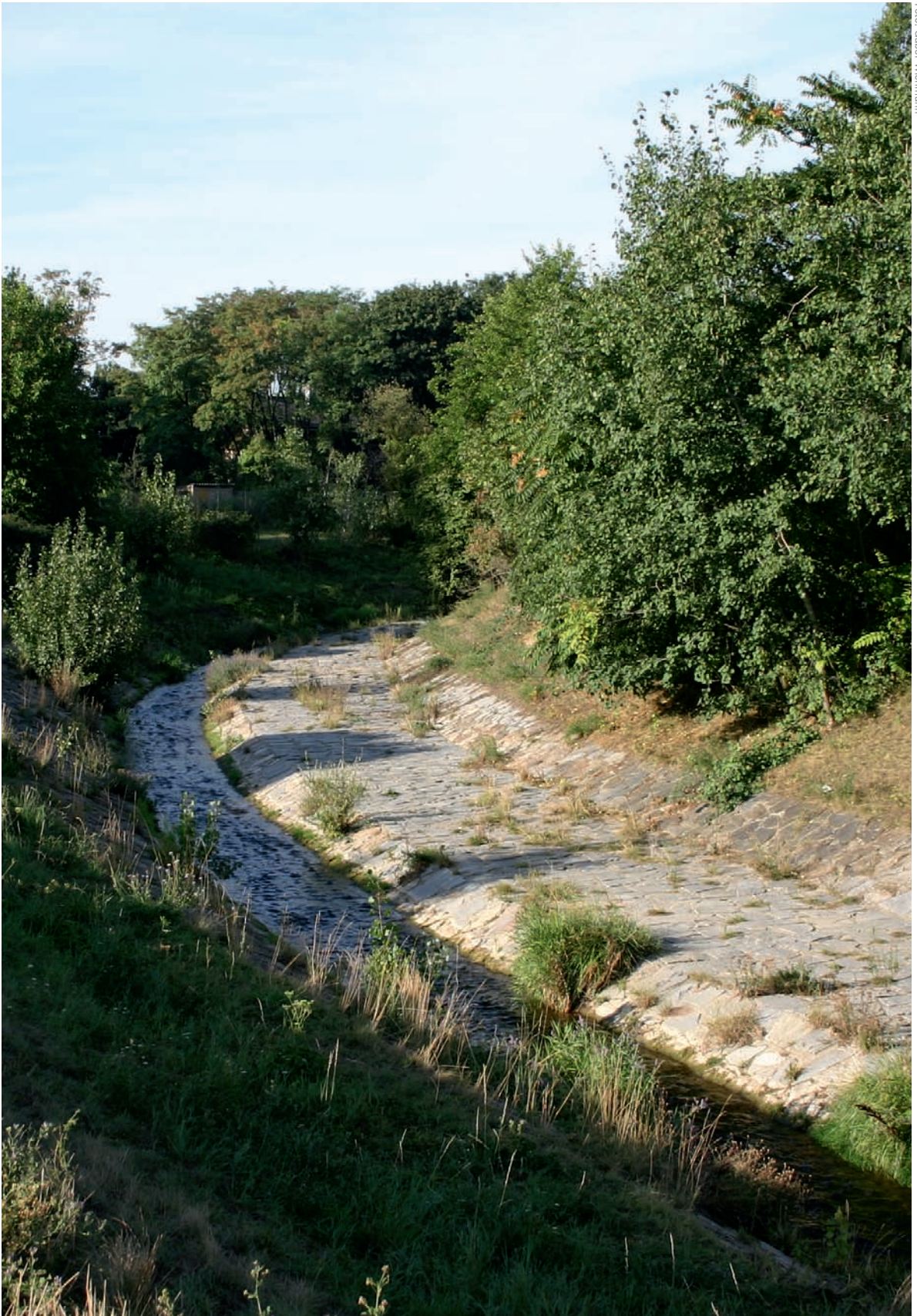
Die hart verbaute Liesing im 23 Gemeindebezirk.
