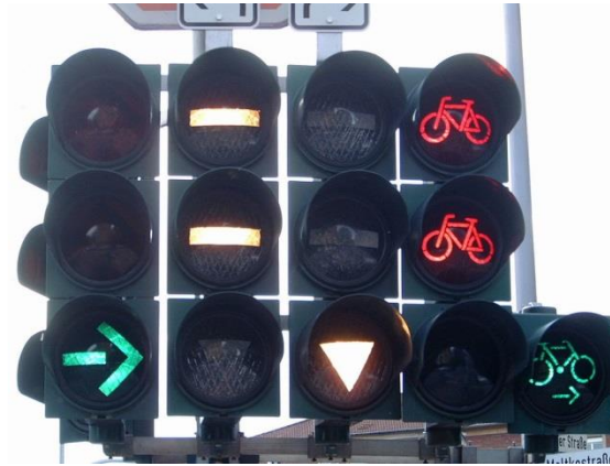
Foto 56: Voorbeeld verkeerslichten uit Barcelona (Foto FDD)
