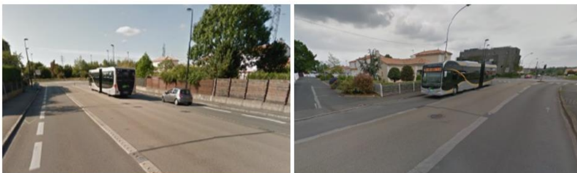
Foto 6 (a+b): Dubbelrichtingsbusbaan 7m en enkele busbaan (wisselstrook) 4m
