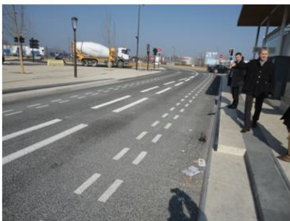
Foto 51: Geleidingssysteem in Nîmes en Rouen, dubbele witte onderbroken lijnen (foto's FDD)
