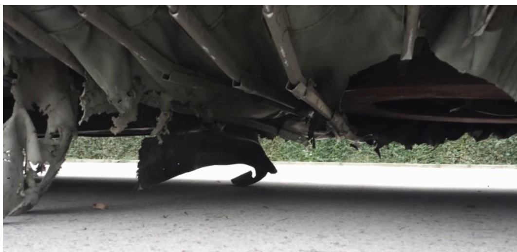
Foto 79: Schade aan de vouwbalg (Foto Bart De Mey)
