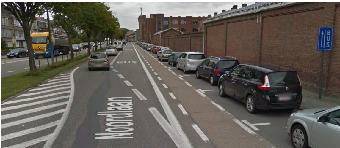
Foto 19: Busbaan Noordlaan – Dendermonde (Google Streetview)
