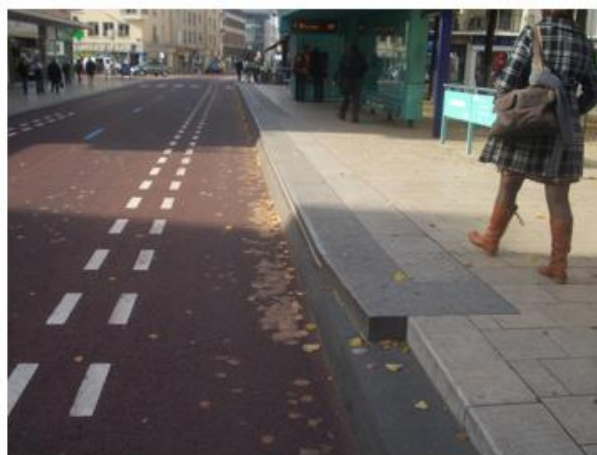
Foto 51: Geleidingssysteem in Nîmes en Rouen, dubbele witte onderbroken lijnen (foto's FDD)
