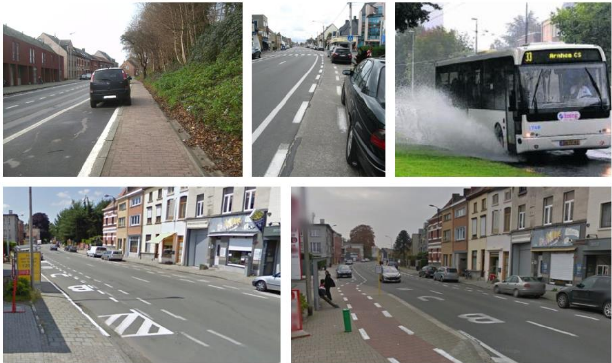
Foto 9 (a+b+c+d+e): Voorbeelden van aanleg niet volgens de normen
