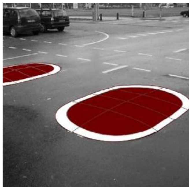
Foto 81: Gevulkaniseerd, trillingsarmer rijbaankussen
