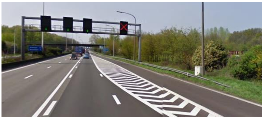
Foto 27: Portieken (foto: Google Streetview)
