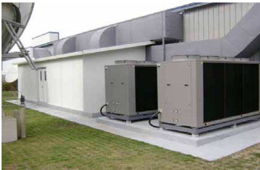
Panorámica de la renovación realizada al sistema de climatización del sitio técnico de Viña del Mar.
