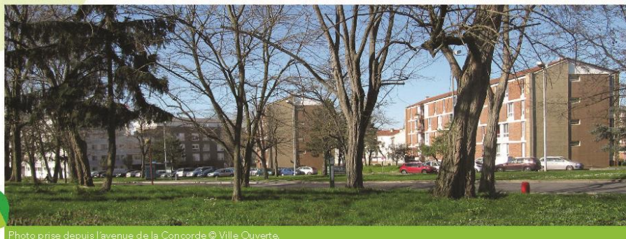
Photo prise depuis l'avenue de la Concorde © Ville Ouverte.
