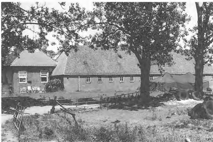
Afb. 2. De boerderij 'de Koningslaagte' in de buurtschap Harssens, onder Adorp, waar Steven Abrahams Cremer zich in 1720 vestigde. Sindsdien is de boerderij enige malen verbouwd. In de oorlogsjaren 1940-1945 is het bedrijfsgedeelte door brand verwoest en in een wat andere vorm herbouwd (foto: B.E. Dop, 1997).
