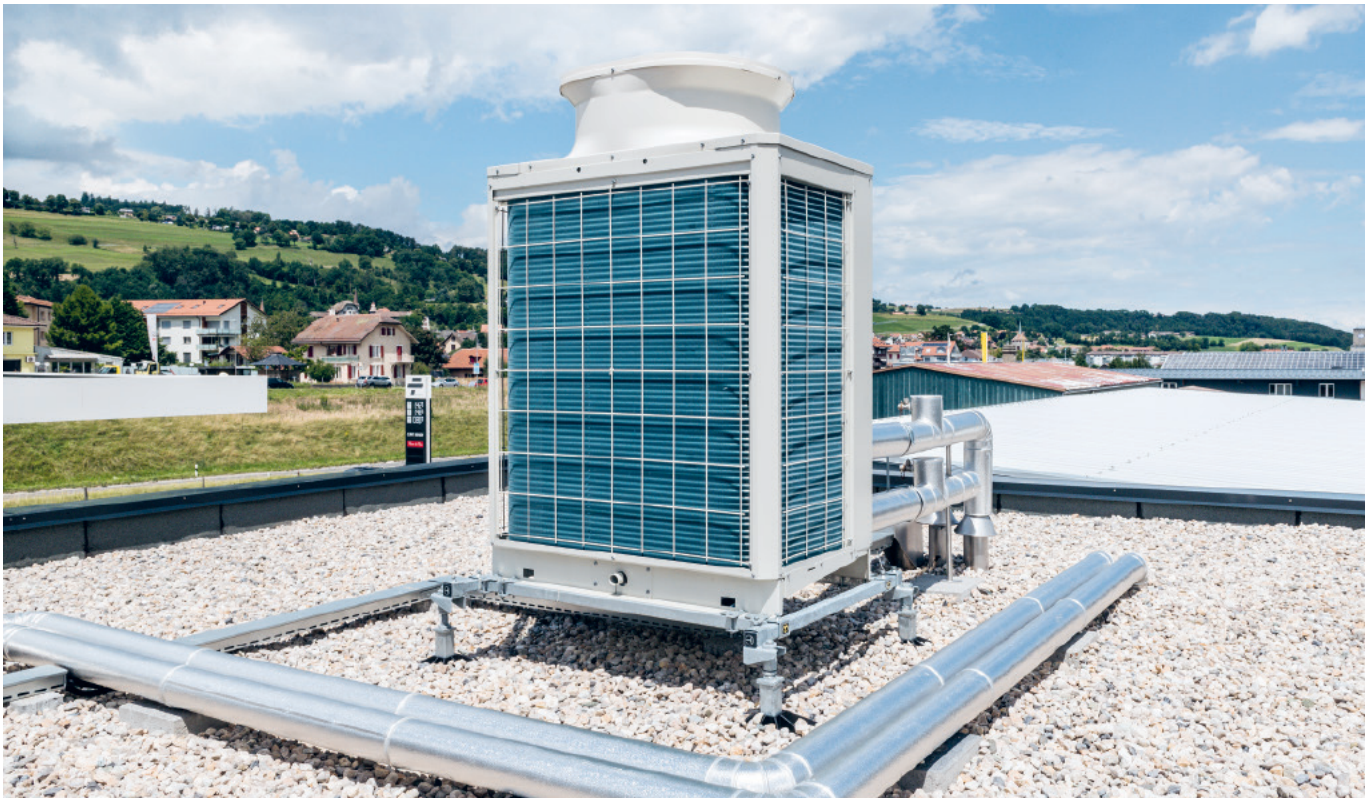
Autowaschanlage, Moudon VD Mehr Referenzanlagen: referenzen.meiertobler.ch
