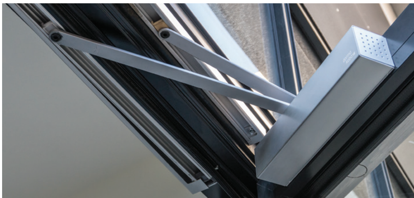
Türschließung gegen Überdruck mit TS 93 auf der Bandgegensseite und Freilauftürschließer TS 99FL auf der Bandseite
