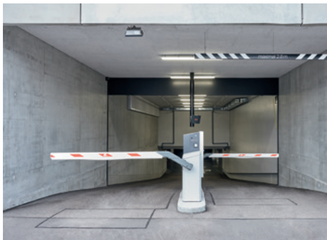
Weitbereichsleser: schnelle und sichere Zugangskontrolle an der Schranke durch reaktionsschnelle Fahrzeugerkennung
