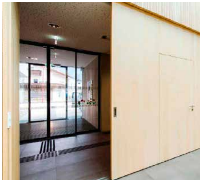
Brandschutzschiebetür Holz, mit Fluchtfunktion
