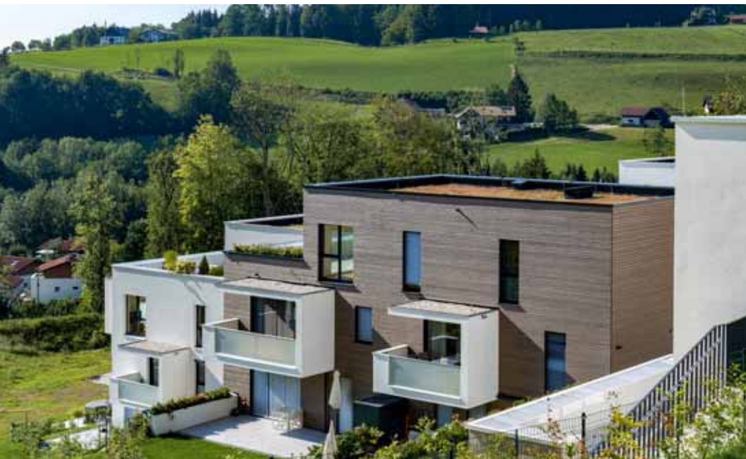
Bramac Flachdach begrünt
