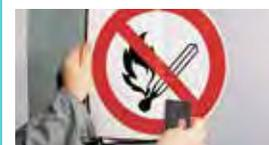
Vor dem Verkleben eines Folienschildes, muss der Untergrund sorgfältig von Staub und Schmutz gesäubert werden. Um Fette oder Öl zu entfernen eignet sich am besten ein entsprechender Sprühreiniger. Nach der Reinigung der Fläche einfach das Schild positionieren und mit der Raket blasenfrei andrücken.
