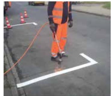
PREMARK® Fahrbahnmarkierungen für Straßen und Verkehrswege zum Aufbrennen auf festem Untergrund, schon nach kurzer Zeit befahr- oder begehbar, bis zu 8 mal haltbarer als aufgesprühte Bodenmarkierungen, Glasperlen erhöhen die Anfangsreflexion und den Warneffekt, rutschhemmende Oberfläche (R12), Selbstreinigungseffekt im Außenbereich, mit ausführlicher Verlegeanleitung.
