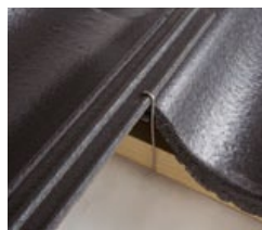
Bindere skal holdes fast i falsen og trykkes på plads om lægten.
