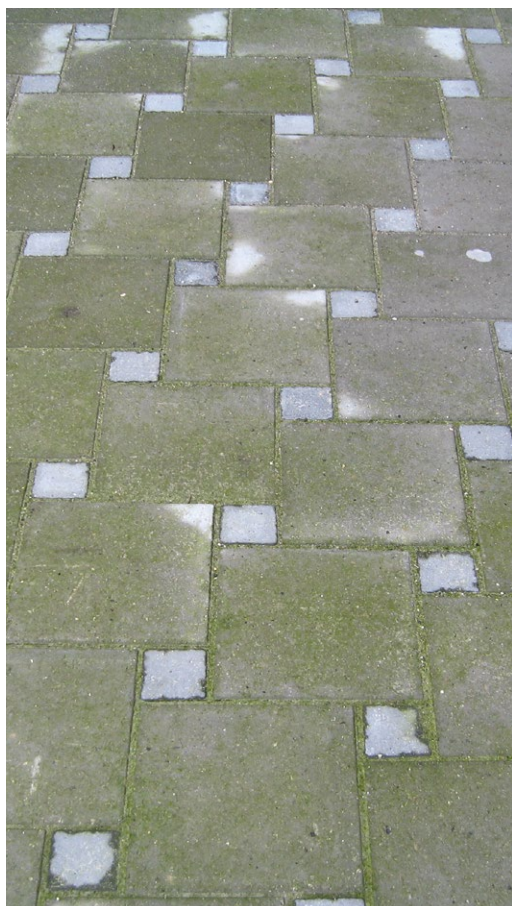
Eksempel på grønalg på fliser. Problemet opstår oftest på skyggefulde områder.
