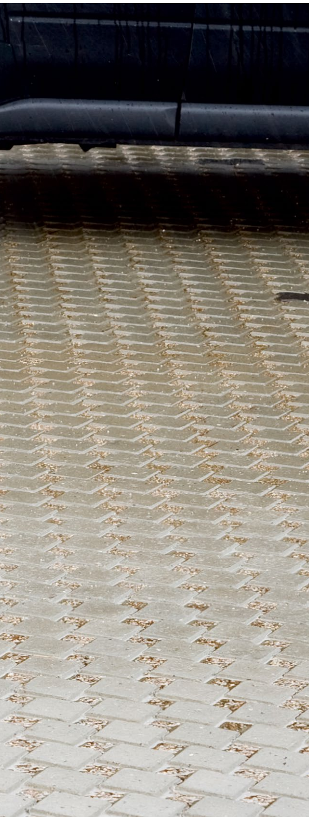
IBF Perma-Drain® med NCC's vandgennemtrængelige materialer i både fuger og bærelag. Vandet transporteres ned gennem befæstelsen uden at miste sin bæreevne.
