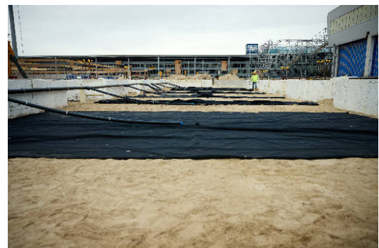
De installatie van de waterberging onder het nieuwe gedeelte van de terminal
