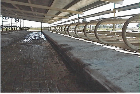
نکاسی کی گزرگاہ میں گائے اور نکاس کی سمت میں جھریاں ڈالی گئی ہیں۔
