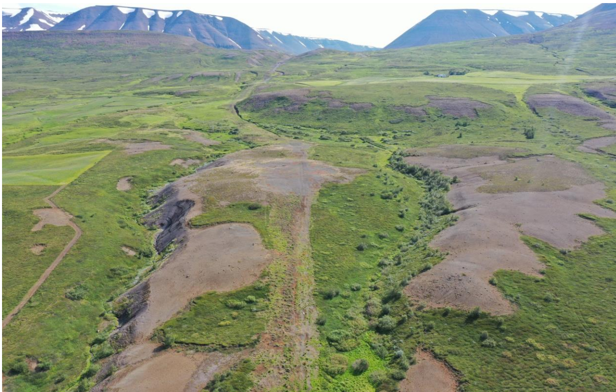
MYND 4.7 Niðurgrafin pípa Hólsvirkjunar á Norðurlandi fjórum árum eftir að framkvæmdum lauk. Ummerki um rasksárið smám saman að hverfa og gróður farinn að vaxa á ný. Mynd: Skírnir Sigurbjörnsson.
