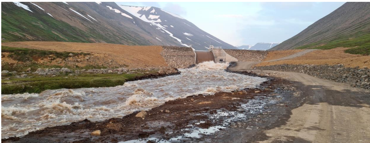
MYND 4.71 Ásýnd jarðvegsstíflu með steypu yfirfalli þegar staðið er beint fyrir framan stíflu. Mynd tekin 2021, fyrsta sumar eftir að framkvæmdum við Hólsvirkjun lauk.
