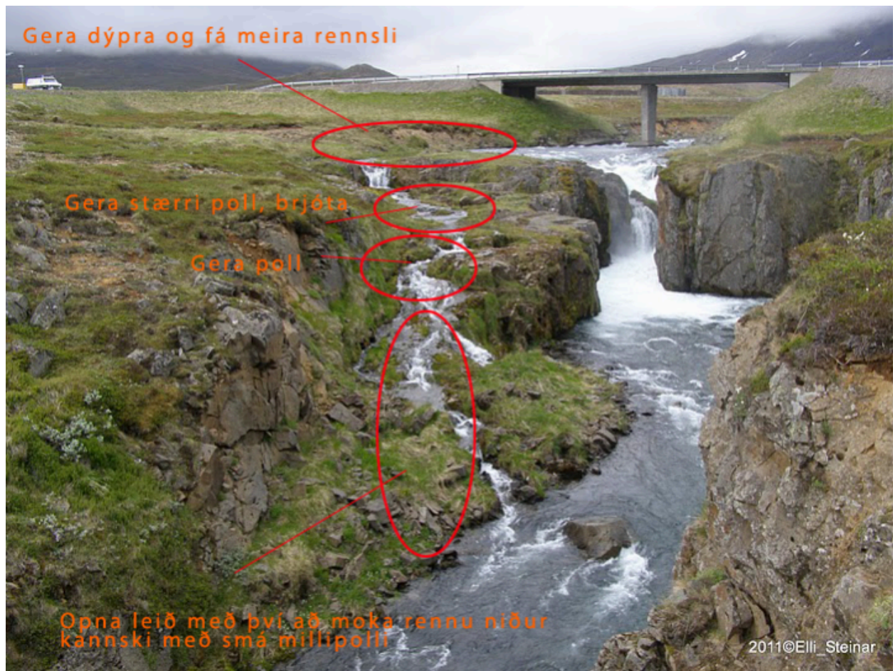
Mynd 3 Hugmyndir að fiskstiga í Þorvaldsdalsárfossi, (Erlendur Steinar 2011)
