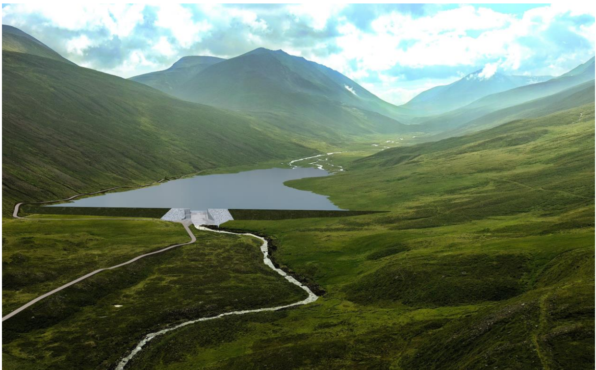
MYND 4.59 Líkanmynd af fyrirhugaðri stíflu og lóni í hæstu stöðu og lítið rennsli um yfirfall. Séð frá öðru sjónarhorni. Með tíð og tíma munu jarðvegsvængir stíflunnar gróa upp.
