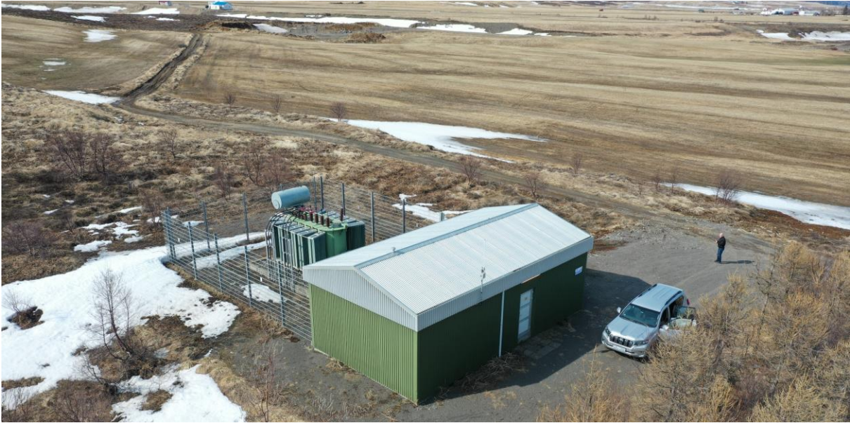
MYND 2.20 Spennistöð RARIK við Stærri-Árskóg. Strengurinn verður plægður meðfram veginum á myndinni og í gegnum námuna uppi vinstra megin.
