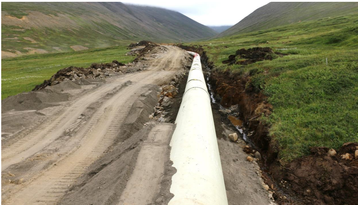
MYND 2.12 Mynd af lagningu aðrennslispípu Hólsvirkjunar á Norðurlandi. Gert er ráð fyrir sambærilegu verklagi við Árskógsvirkjun.
