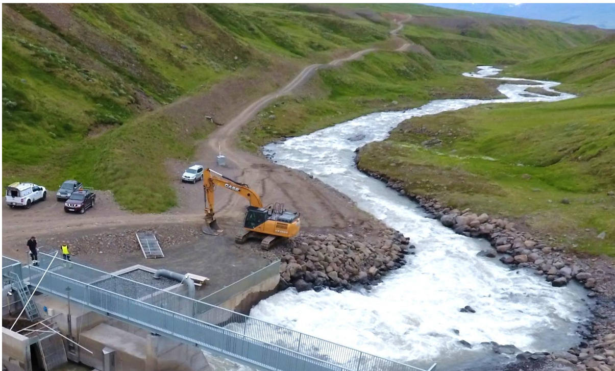
MYND 4.10 Glerárvirkjun II í Eyjafirði. Hér má sjá veg og niðurgrafna pípu í 300 m.y.s. Mynd tekin 2021, þrem árum eftir að virkjunin var tekin í notkun. Frágangur rasks og endurheimt gróðurs hefur tekist vel.
