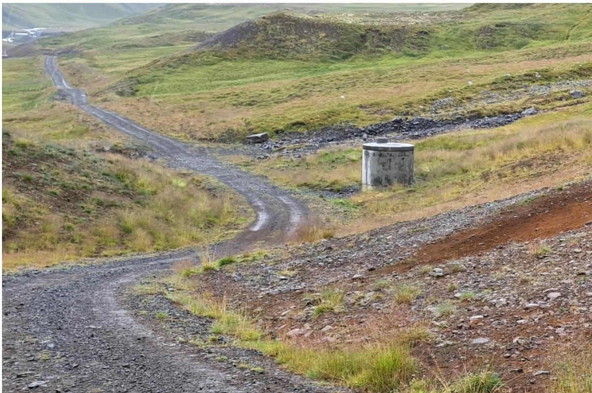
MYND 4.66 Ásýnd eftir vegi og niðurgrafinni pípu Glerárvirkjunar II. Stíflumannvirki sjást efst til vinstri, mynd tekin í rúmlega 300 m.y.s. fimm árum eftir að framkvæmdum lauk. Steypt mannvirki við veginn er jöfnunarpró virkjunarinnar.
