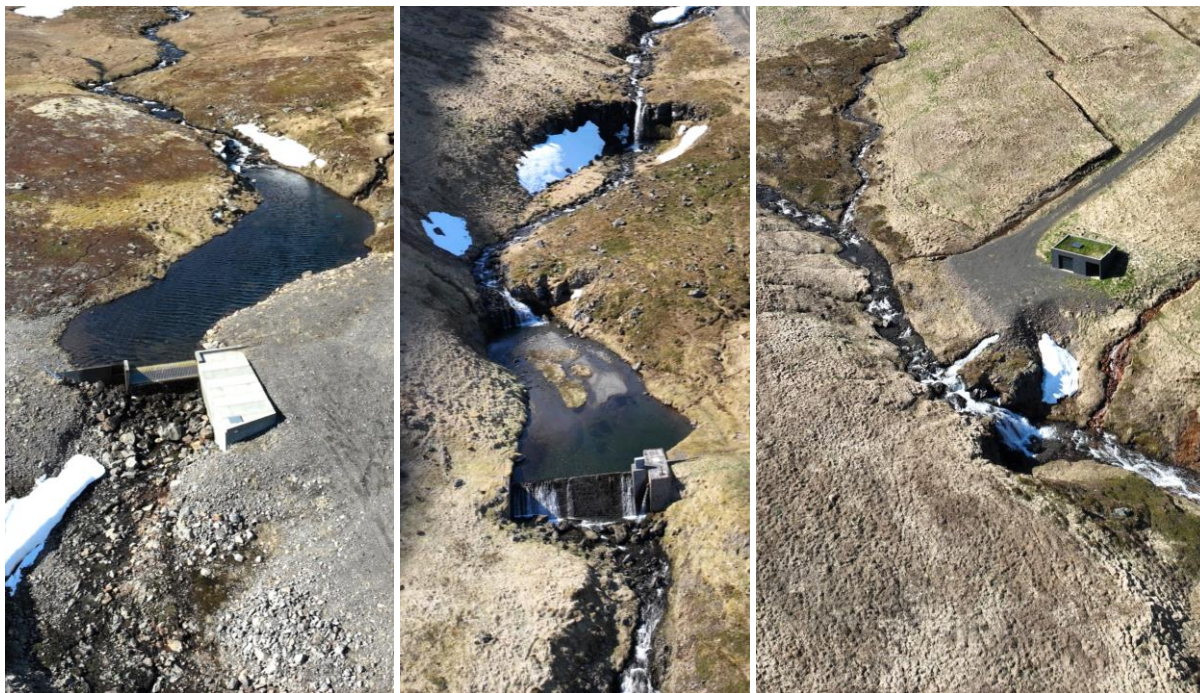
MYND 4.32 Úlfsárvirkjun á Vestfjörðum. Til vinstri sést inntakið þegar ekkert rennur um yfirfall og farvegur er þurr strax neðan stíflu. Fyrir miðju er rennsli við gamalt vatnsból um 1 km neðan inntaks, og til hægri sést hvar vatn kemur aftur út í farveg frá stöðvarhúsi um 2 km neðan inntaks. Farvegur er ekki þurr nema allra næst stíflu og við stöðvarhús er vatn bakka á milli.
