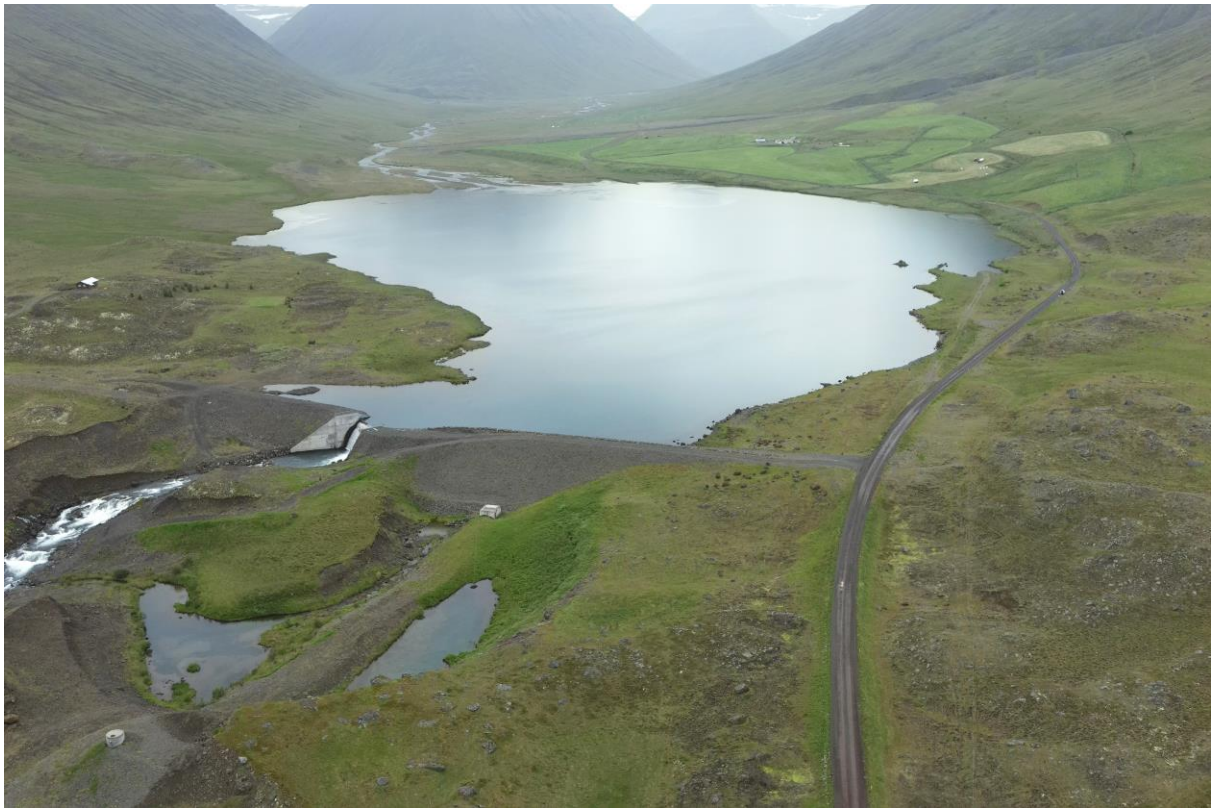
MYND 4.51 Lón Djúpadalsvirkjunar II er gott dæmi um lón í þröngum jökulsorfnnum fjalladal í Eyjafirði. Stíflan er 260 m löng og lónið er um 40 ha. Til samanburðar verður stífla Árskógsvirkjunar um 450 m löng og lón um 25 ha.
