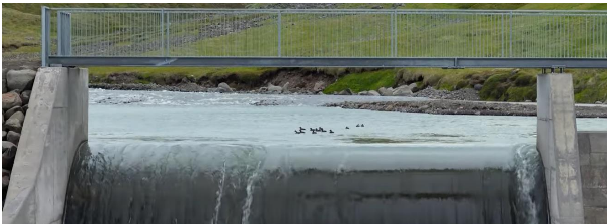
MYND 4.16 Straumandahópur á inntakslóni Glerárvirkjunar 2 í Glerárdal í Eyjafirði. Mynd: Gylfi Gylfason.
