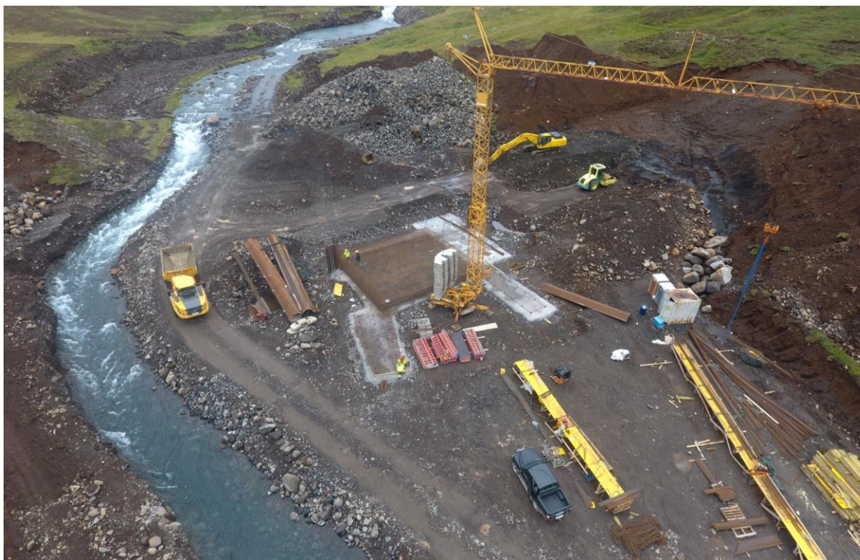
MYND 4.43 Á framkvæmdatíma eru ár settar í farveg til að halda þeim frá framkvæmdasvæði. Engin gruggmyndun verður nema meðan á færslu stendur. Mynd frá Hólsvirkjun á framkvæmdatíma í ágúst 2019.
