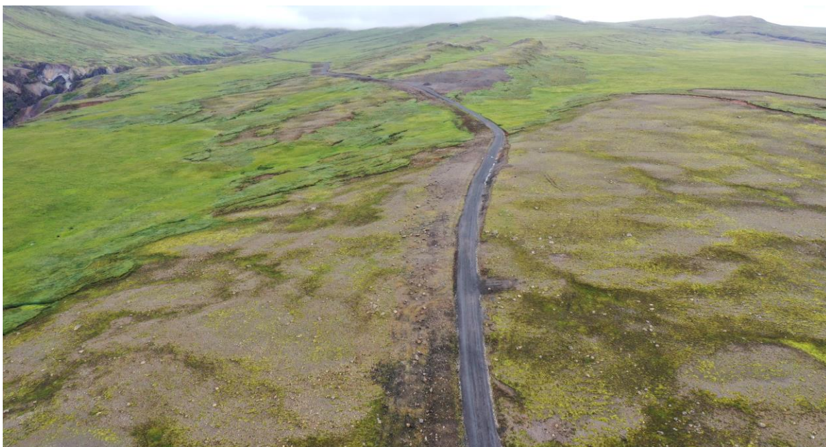
MYND 4.8 Vegur og niðurgrafin pípa Þverárvirkjunar í Vopnafirði. Mynd tekin 2024, fyrsta sumarið eftir að framkvæmdum lauk. Mynd: Skírnir Sigurbjörnsson
