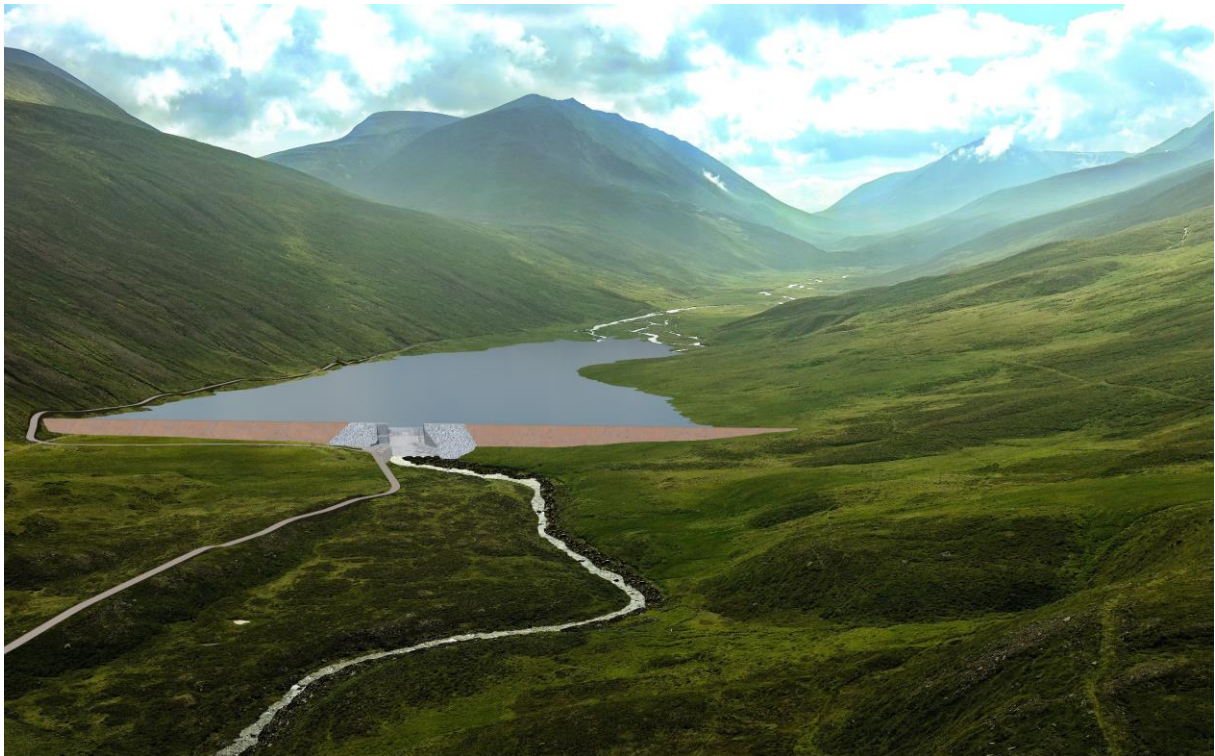
MYND 4.58 Líkanmynd af fyrirhugaðri stíflu og lóni í hæstu stöðu og lítið rennsli um yfirfall. Séð frá öðru sjónarhorni. Fyrst eftir að framkvæmdum lýkur eru jarðvegsvængir stíflunnar ógrónir.
