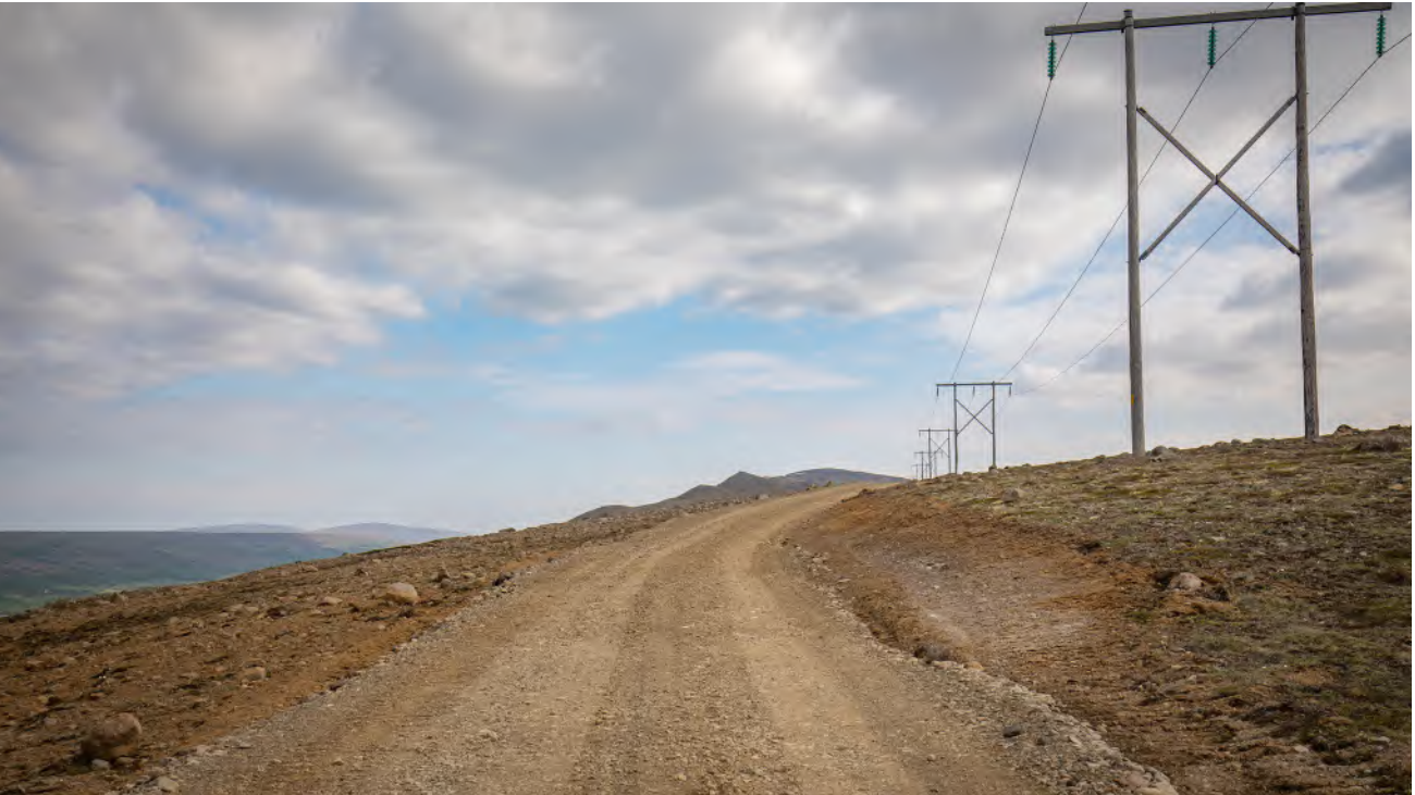
Dæmi 4. Nýleg línuslóð vegna Hólasandslínu 3
