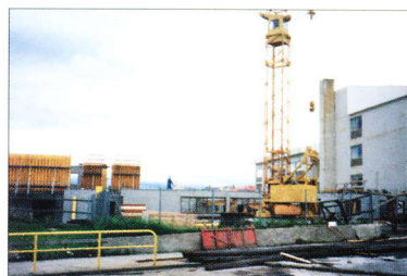
Frá byggingu heilsugæslustöðvar.
