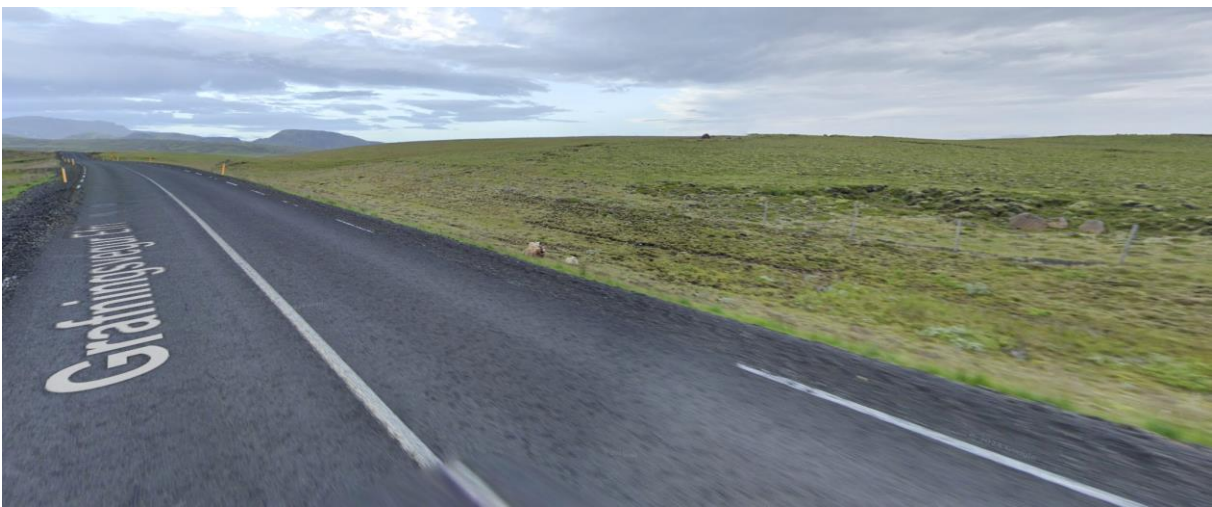
MYND 6.35 Núverandi ásjnd frá Grafningsvegi efri, austanmegin á jörðinni. Horft í norðvesturátt. Hæðir byrgja sýn í átt til Villingavatns og Þingvallavatns. Mynd: Google Maps, ágúst 2024.
