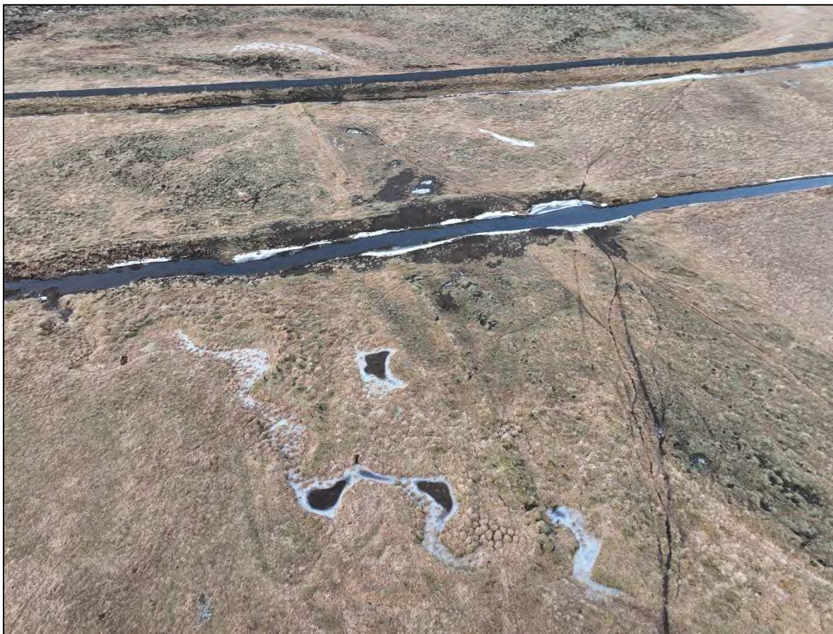
Mynd 8. Skálholtsrimi [3382-311] (fyrir miðri mynd) er hlaðin gata yfir mýrina. Búið er að grafa skurði í gegnum garðinn.
