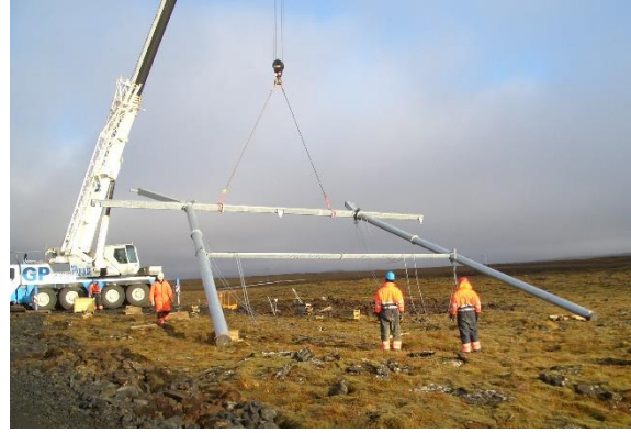
Mynd 6.12 Sýnt frá vinnu við samsetningu og reisingu stagaðs burðarmasturs af M-gerð með jarðvirsreyrum. Myndirnar eru frá byggingu Reykjaneslínu 1.
