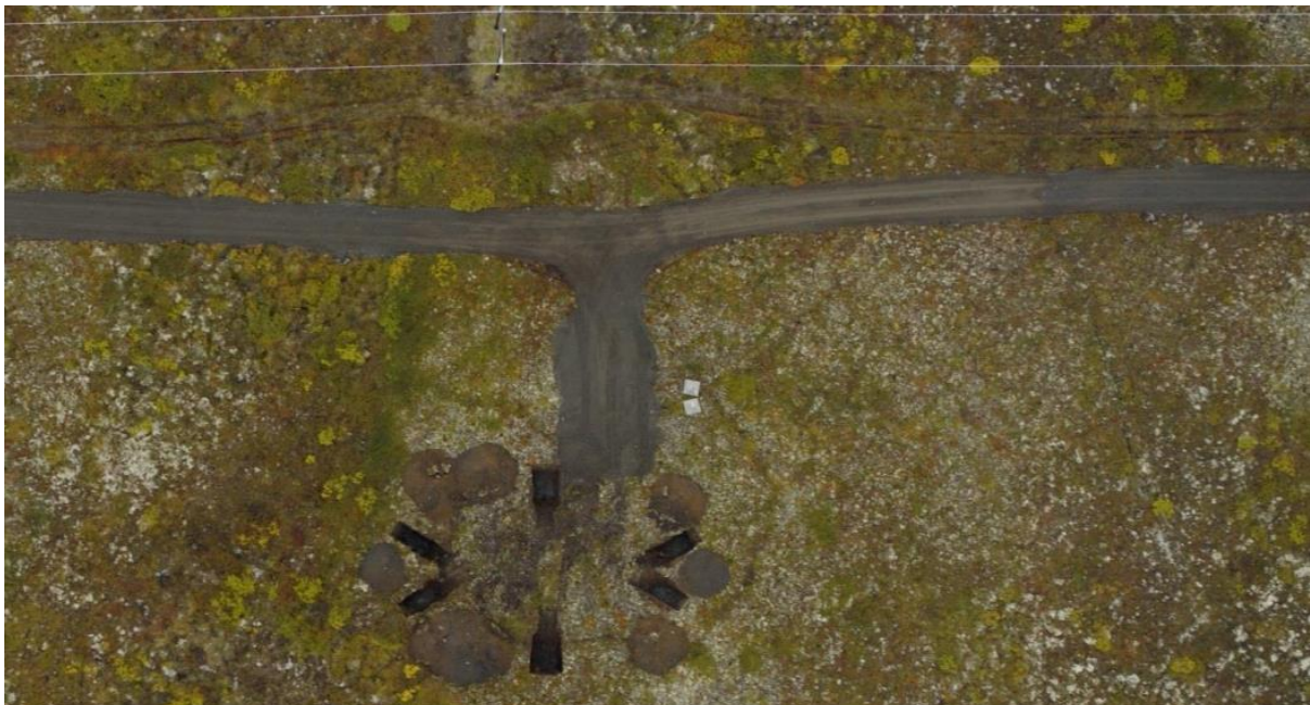
Mynd 6.13 Gröftur fyrir forsteyptum undirstöðum og stagfestum á framkvæmdatíma á masturstæði í Kröflulínu 3.
