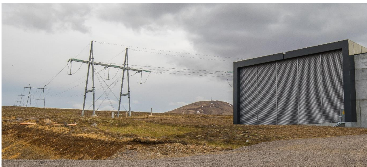
Mynd 6.4 Dæmi um enda- og hornmastur, með jarðvírseyrum við tengivirki.
