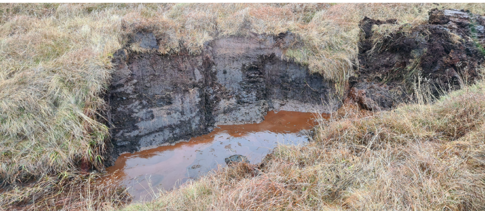
Mynd 9. Þegar þverbönd eru útbúin þarf að hreinsa allan gróður úr botni og af bökkum skurðarins
