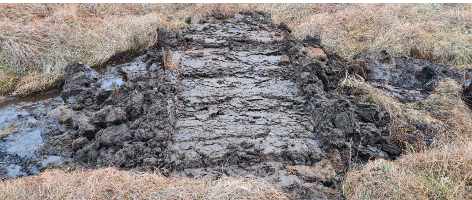
Mynd 10. Þverbönd eiga helst að vera úr hreinum jarðvegi sem er vel þjappaður. Þau eru síðan torflögð
