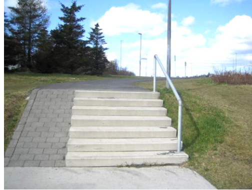
Mynd 15 Gönguleið upp frá undirgöngum undir Lækjargötu. Horft til vesturs. Óþarflega bratt er upp rampann. Hægra megin má sjá slóða eftir þá sem velja sér leið með minni halla.
