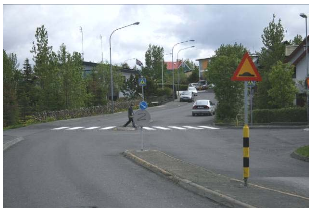
Mynd 8.2. Gangbraut yfir Hraunbrún við Garðaveg. Gróður skyggir á gangandi vegfarendur
