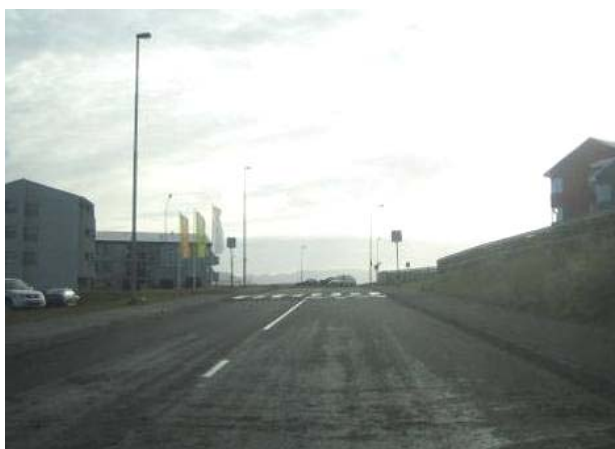
Mynd 5.2. Hvaleyrarbraut, ekið í átt að gangbraut.
