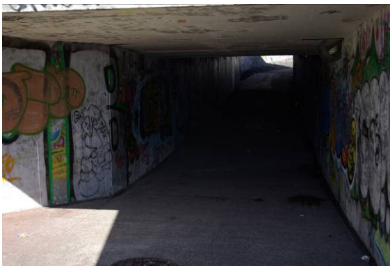
Mynd 36 Undirgöng undir Reykjanesbraut milli Setbergs og Lækjarskóla. Aðkoman að undirgöngunum Setbergsmeginn er í boga þ.a. göngin eru skuggaleg og virka lokuð.
