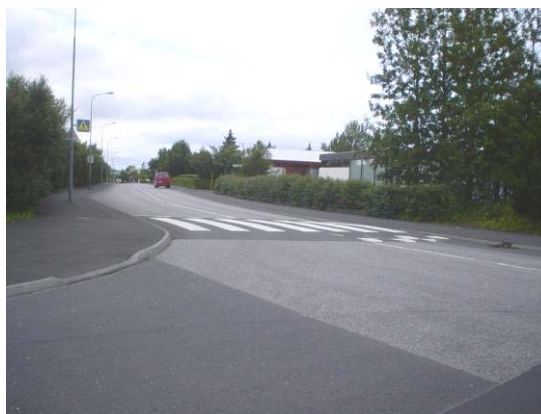
Mynd 6.3. Gangbraut yfir Álfaskeið við Sólvangsveg.
