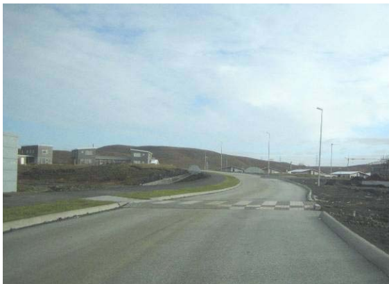
Mynd 4.3. Hraðahindrun og undirgöng yfir Fléttuvelli við Glitvelli.
