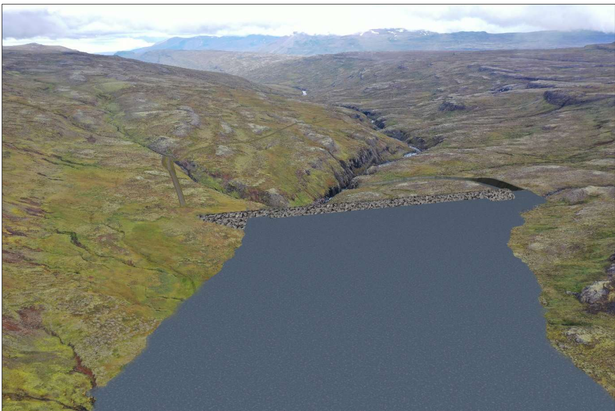
Mynd 5.14 Fyrirhuguð stífla og inntakslón Geitdalsárvirkjunar, séð úr lofti til norðurs. Yfirfall virkjunar er hægra megin við stífluna. Staðsetning sjónarhorns er punktur nr. 5 á mynd 5.9.
