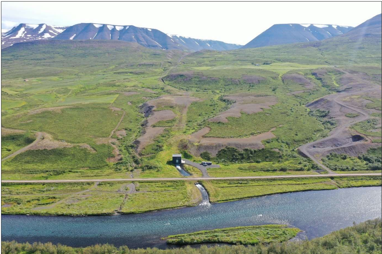
Mynd 3.24 Hólsvirkjun í Fnjóskadal, 6,7 MW virkjun sem gangsett var árið 2020. Sjá má að landið er langt komið með að jafna sig þar sem þrýstipípan liggur ofan við stöðvarhúsið og bakkar frárennslisskurðarins eru orðnir vel grónir.
