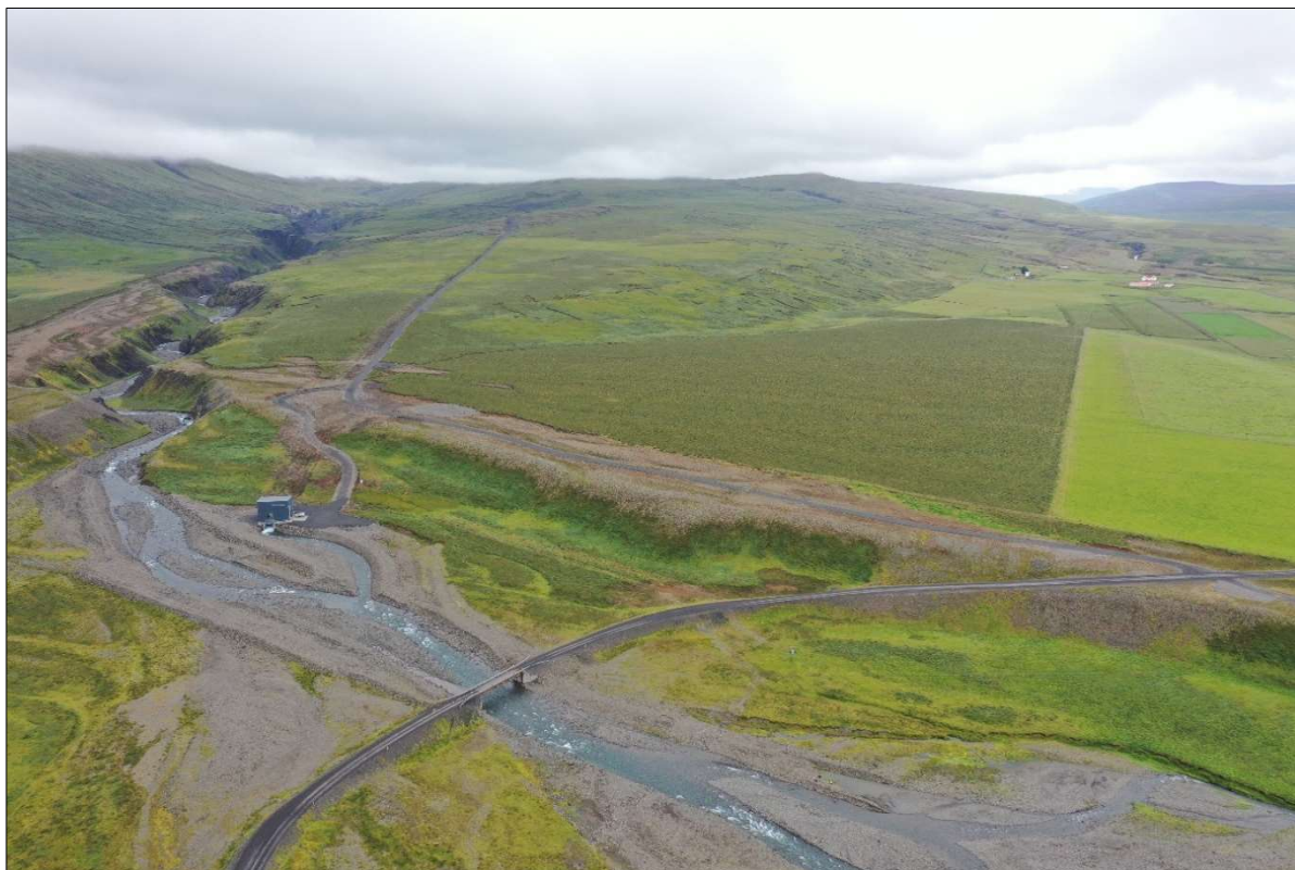
Mynd 3.25 Þverárvirkjun í Vopnafirði, 6 MW virkjun sem gangsett var í árslok 2022. Rask á landi er helst bundið aðkomuvegi frá stöðvarhúsi að stíflu en eins og sjá má er sár í landi einungis ármegin vegarins.
