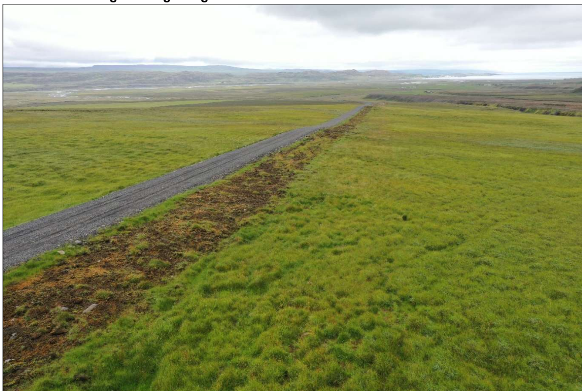
Mynd 3.26 Hér má sjá nærmynd af aðkomuveginum, sem var á köflum lagður yfir votlendi. Eins og sjá má er landið áfram vel blautt enda vegurinn lagður „fljótandi“. Sárið í vegkantinum er á góðri leið með að gróa.
