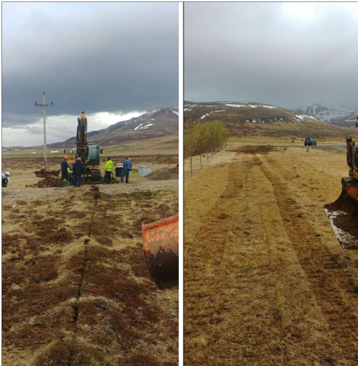
Mynd 3.14 Myndir sem sýna ummerki eftir lagningu jarðstrengs á tveimur mismunandi stöðum. Á myndinni til vinstri hefur strengur verið plægður niður en frágangur er eftir. Myndin til hægri sýnir ummerki að frágangi loknum.
