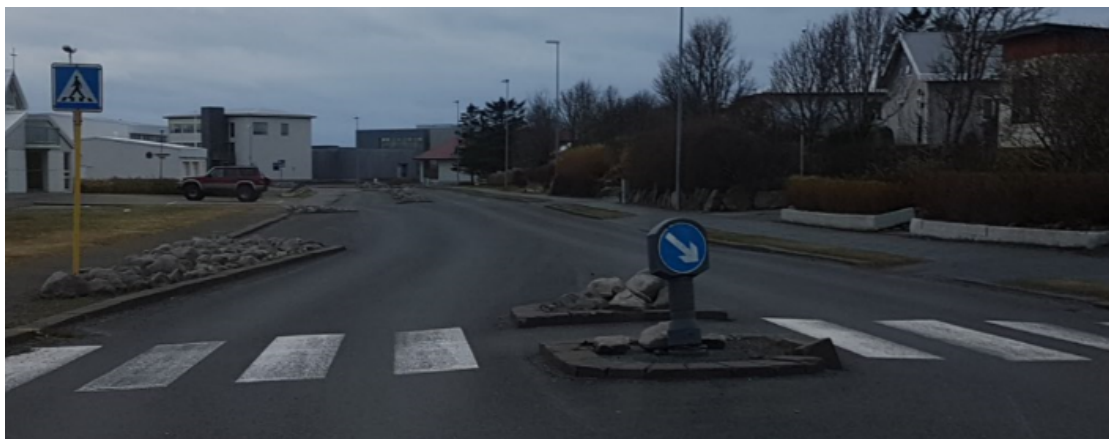
Mynd 22. umdeildar umferðareyjur með stóru grjóti sem getur skapað hættu.
