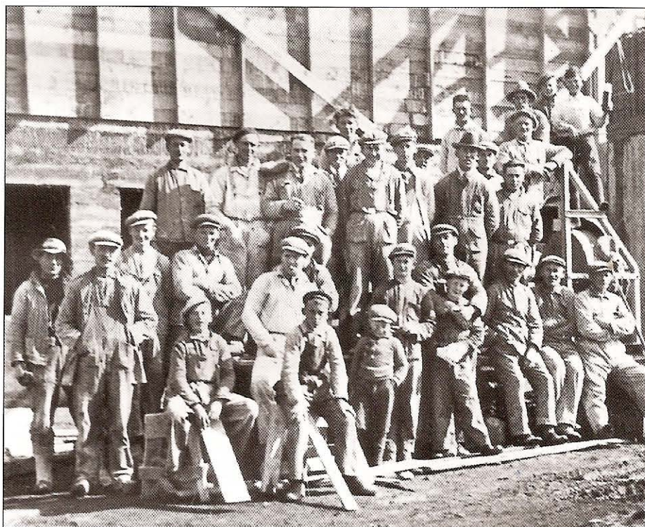
Iðnaðarmenn og verkamenn við byggingu St. Franciskusspítalans í Stykkishólmi 1933–1935.
