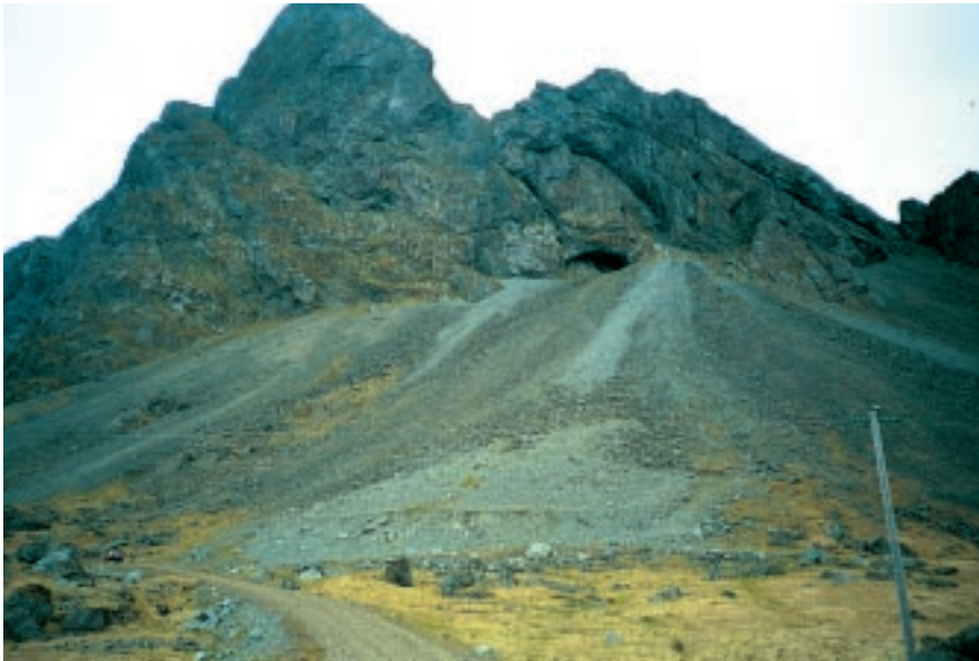
Mynd 9.5: Hvalnesnáma í skriðum Eystraborns fyrir frágang. Á myndinni sést vegur að námunni og námustallur.
