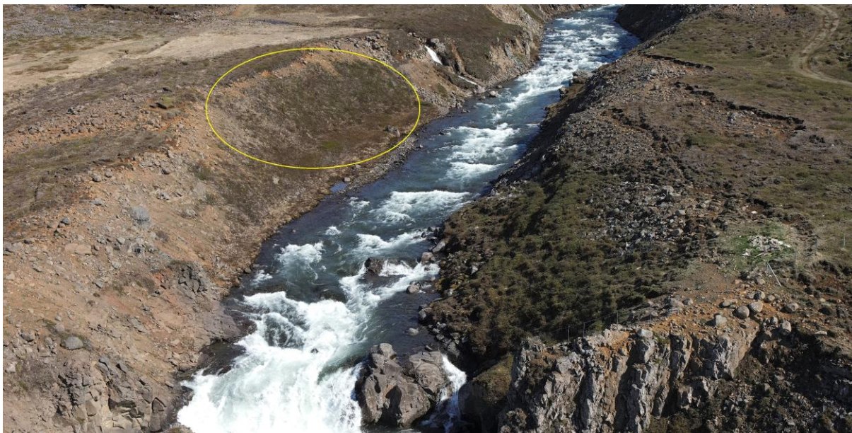
MYND 4.16 Stöðvarhús Gilsárvirkjunar verður byggt inn í brekkuna á myndinni. Jafnframt þarf að skera úr brekkunni og gera sneiðing niður að ánni fyrir vinnuvélar og þjónustu við virkjun. Nykurfossar sjást neðst á myndinni.
