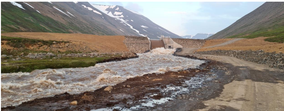
MYND 4.76 Ásýnd jarðvegsstíflu með steypu yfirfalli þegar staðið er beint fyrir framan stíflu. Mynd tekin 2021, fyrsta sumar eftir að framkvæmdum við Hólsvirkjun lauk.
