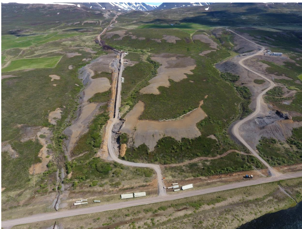
MYND 2.15 Lagning aðrennslispípu Hólsvirkjunar á Norðurlandi. Mynd tekin á framkvæmdatíma þann 15. júní 2019.
