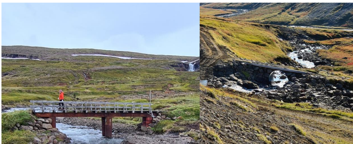
MYND 4.54 Helstu mannvirki í Gilsárdal, fyrir utan núverandi veg, er fjárbrú yfir Innri-Lambadalsá og ræsi í Ytri-Lambadalsá.
