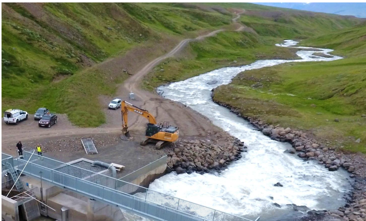
MYND 4.14 Glerárvirkjun II í Eyjafirði. Hér má sjá veg og niðurgrafna pípu í 300 m.y.s. Mynd tekin 2021, þrem árum eftir að virkjunin var tekin í notkun. Frágangur rasks og endurheimt gróðurs hefur tekist vel.
