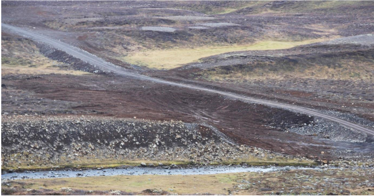
MYND 2.19 Náma við Hólsvirkjun á Norðurlandi skömmu eftir að frágangi lauk haustið 2020.
