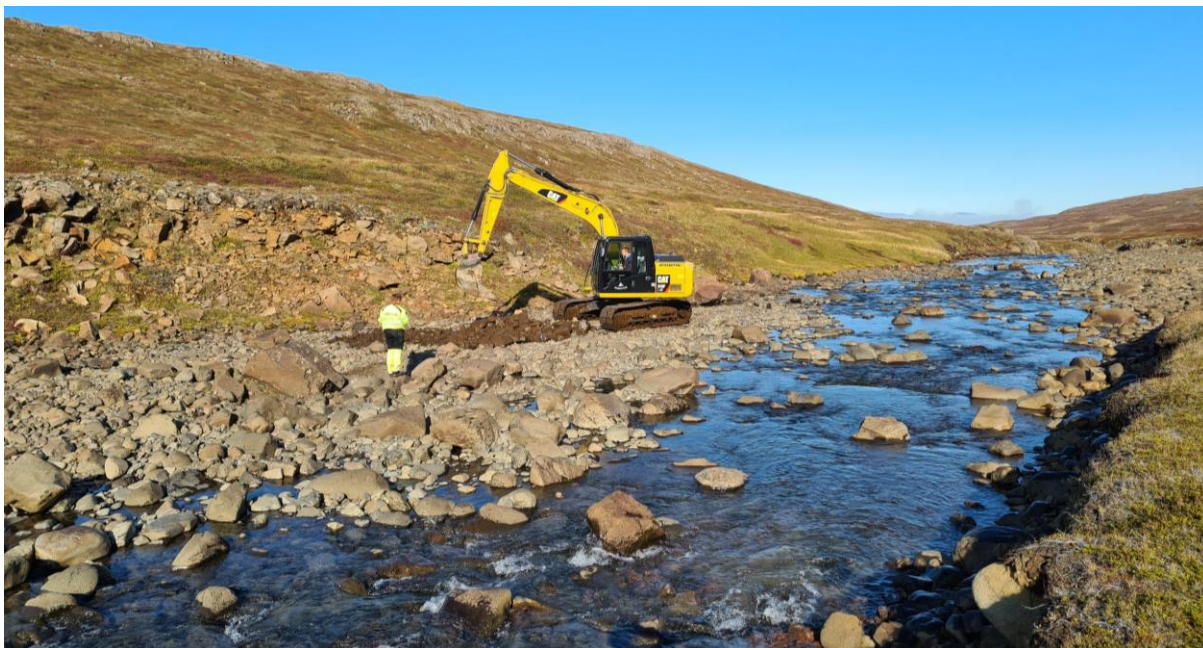
MYND 4.43 Jarðkönnunarhola í stíflustæði Gilsár. Það að grafið sé nálægt á er ekki sjálfkrafa ávísun á að hún gruggist.
