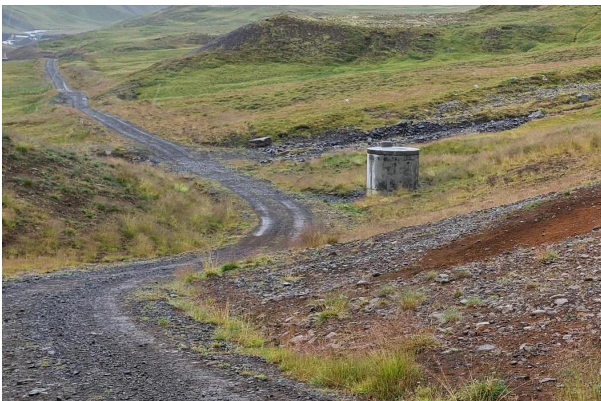
MYND 4.72 Raunveruleg ásjnd eftir vegi og niðurgrafinni pípu Glerárvirkjunar II. Stíflumannvirki sjást efst til vinstri, mynd tekin í rúmlega 300 m.y.s. fimm árum eftir að framkvæmdum lauk. Steypt mannvirki við veginn er jöfnunarþró virkjunarinnar.
