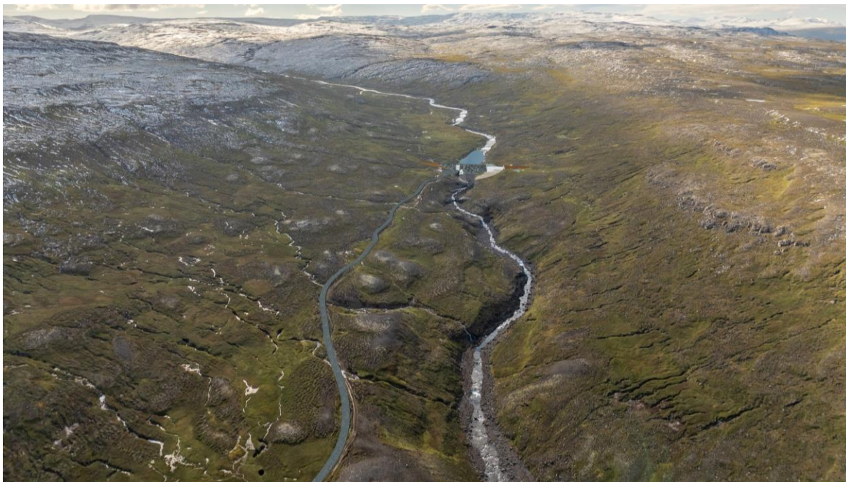
MYND 4.61 Mannvirki á Gilsárdal. Lón í lægstu stöðu og skert rennsli í farvegi. Horft til suðurs, Fjarðarheiði í fjarska.
