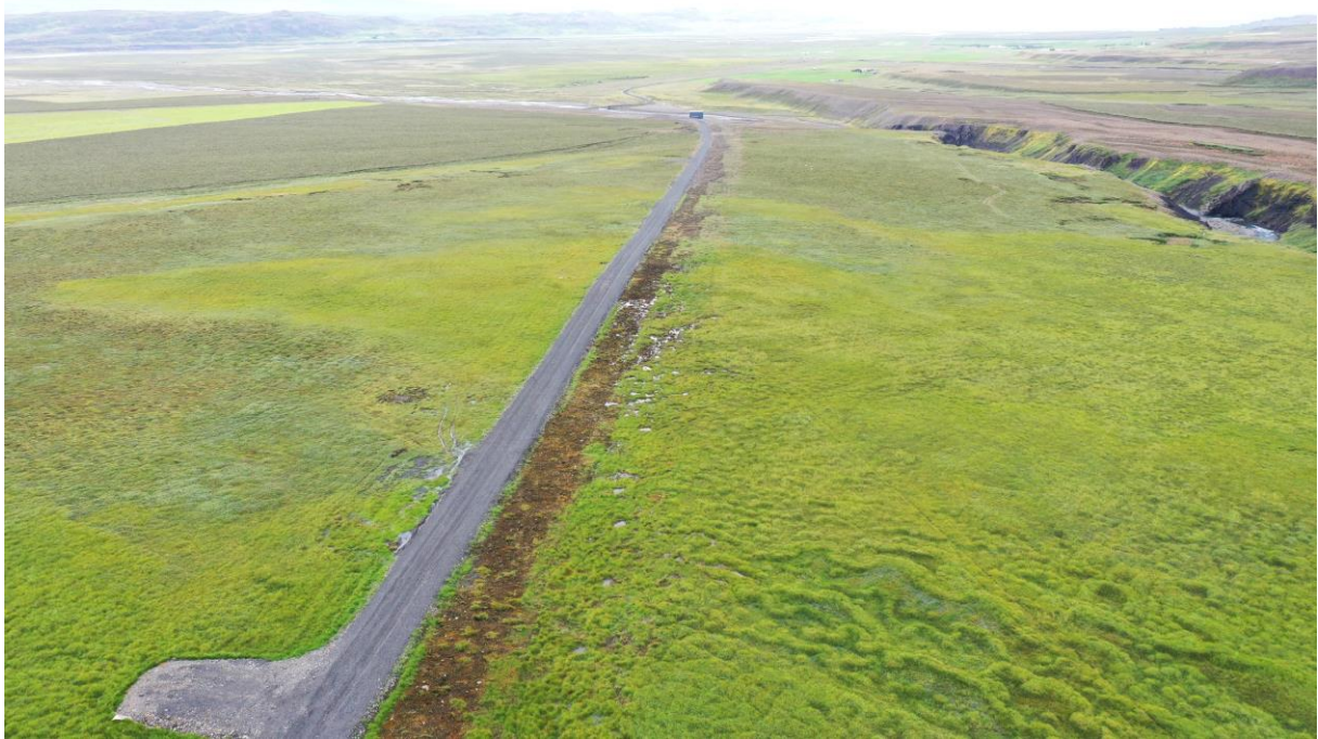
MYND 4.19 Mynd frá Þverárvirkjun í Vopnafirði þar sem vegur og pípa þvera votlendi. Vegurinn er svokallaður fljótandi vegur ofan á votlendinu, grunnvatn getur því flætt óhindrað um votlendið undir veginn. Pípan liggur í vatnsmettuðum jarðvegi og sárið á yfirborði mun gróa, en þessi mynd er tekin fyrsta sumarið eftir að framkvæmdum lauk. Í tilviki Gilsárvirkjunar mun vegurinn liggja utan við votlendið, engin skerðing verður því á votlendi. Mynd: Skírnir Sigurbjörnsson
