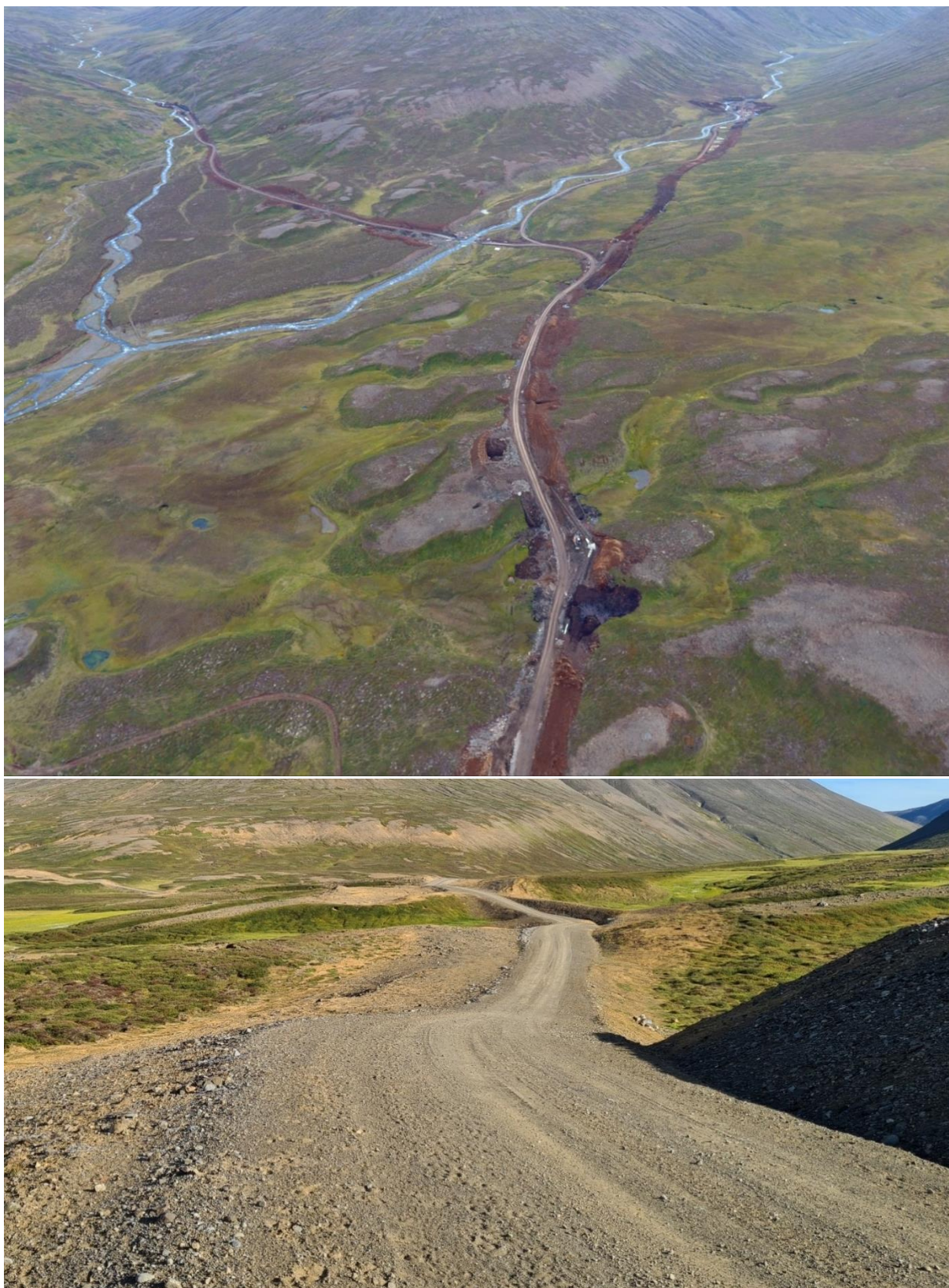
MYND 2.8 Vegur að Hólsvirkjun í Fnjóskadal og niðurgrafin pípa. Efri mynd tekin á framkvæmdatíma í september 2019, og sú seinni sumarið 2023, fjórum árum eftir að vegurinn var lagður og tæpum þrem árum eftir að framkvæmdum lauk. Stefnt er að sambærilegum vegi við Gilsárvirkjun. Gott dæmi um raunverulegan frágang og á efri mynd sést að varanlegur vegur liggur ekki alltaf meðfram pípu.
