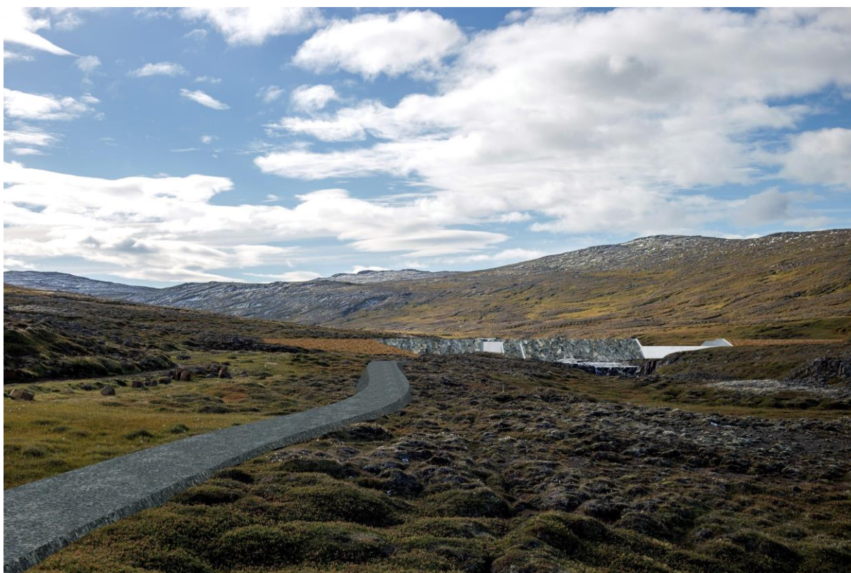
MYND 4.75 Líkanmynd 6. Horft í suður að stíflu Gilsárvirkjunar úr móunum um 200 m neðan við stíflu. Steypt yfirfall kemur í ljós. Skert rennsli í farvegi neðan stíflu. Efri myndin er óbreytt grunnástand.
