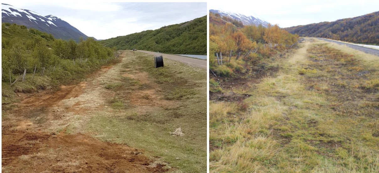
MYND 2.29 Myndir af framkvæmdasvæði 33 kV jarðstrengs Hólvirkjunar meðfram Fnjóskadalsvegi. Til vinstri er strengsárið skömmu eftir frágang sumarið 2019, og til hægri er sama svæði haustið 2021.
