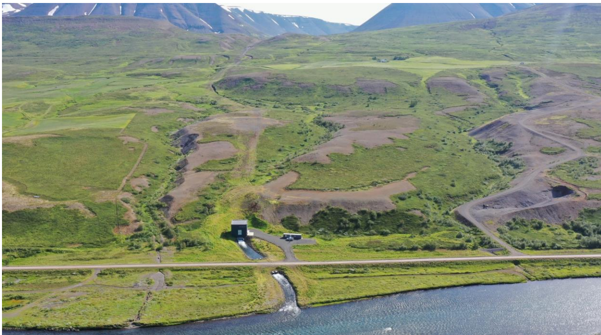
MYND 2.16 Mynd tekin 31. júlí 2024 sem sýnir að ummerki um framkvæmdir við aðrennslispípu eru að mestu horfin. Varanlegur vegur liggur ekki alltaf meðfram pípu. Mynd: Skírnir Sigurbjörnsson
