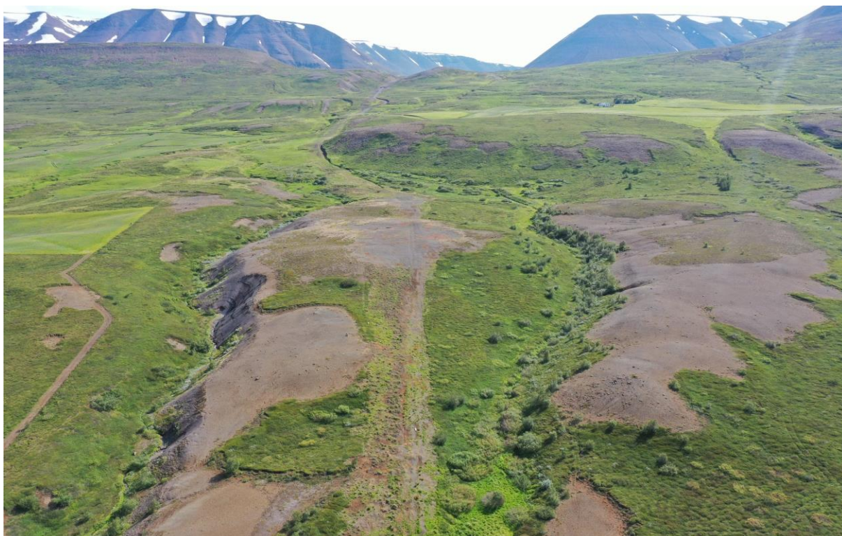
MYND 4.11 Niðurgrafin pípa Hólsvirkjunar á Norðurlandi fjórum árum eftir að framkvæmdum lauk. Ummerki um rasksárið smám saman að hverfa og gróður farinn að vaxa á ný. Mynd: Skírnir Sigurbjörnsson.
