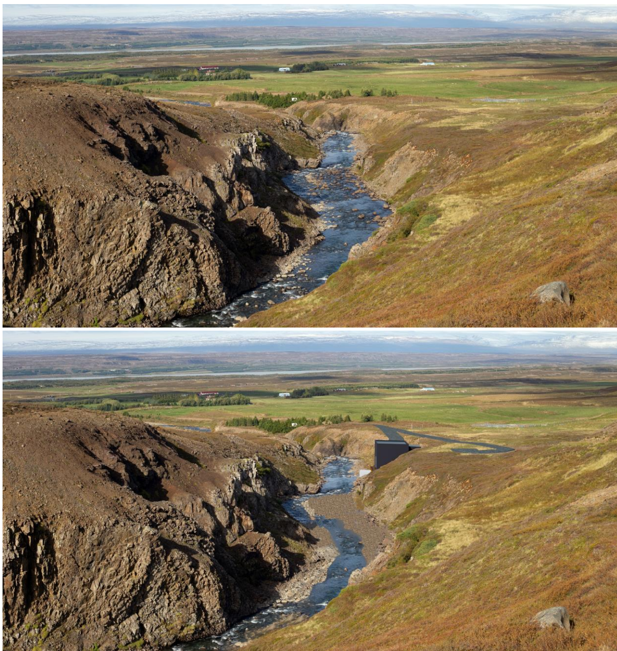
MYND 4.70 Líkanmynd 3. Stöðvarhús Gilsárvirkjunar séð úr brekkunni ofan frá. Skert rennsli ofan stöðvarhúss. Horft í vestur út yfir Eiðabíngahá, Lagarfljót í fjarska. Efri myndin er óbreytt grunnástand.
