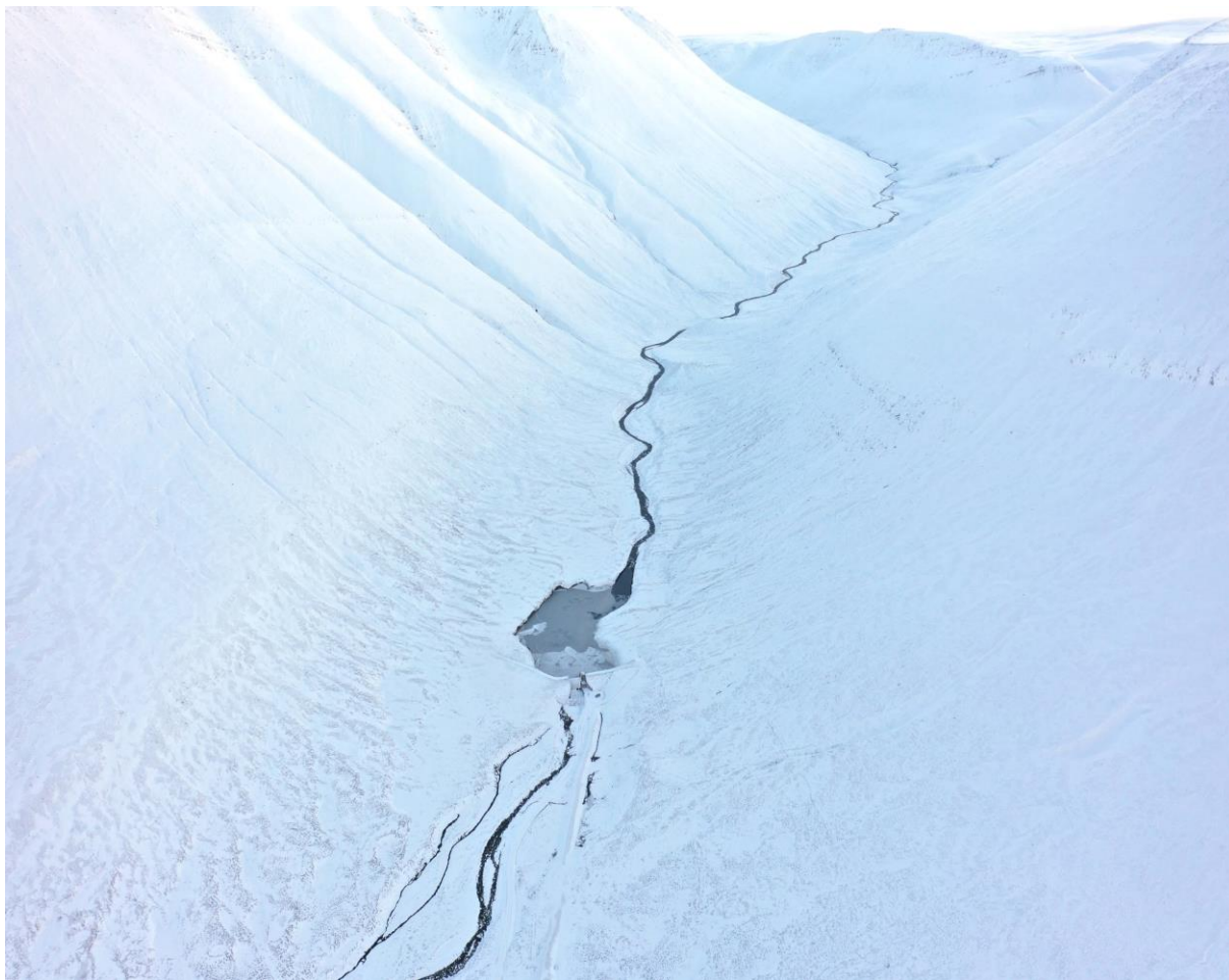
MYND 4.33 Raunaðstæður við Hólsvirkjun á Norðurlandi að vetri til er allt rennsli árinna fer í aðrennslispípu og ekkert rennur um yfirfall. Mjög fljótlega bætast við lindir og lækir sem viðhalda rennsli og vatni í farveginum. Mynd: Skírnir Sigurbjörnsson.
