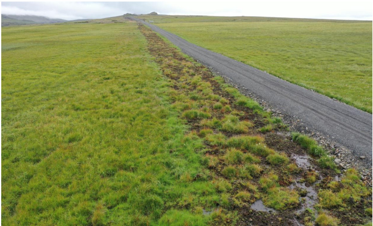
MYND 4.20 Mynd frá Þverárvirkjun í Vopnafirði þar sem vegur og pípa þvera votlendi. Gróðurlag var geymt og sett aftur á rasksár að framkvæmdum loknum, staðargróður er því strax byrjaður að endurheimta yfirborð pípuleiðar og votlendið enn vatnsmettað. Mynd: Skírnir Sigurbjörnsson.
