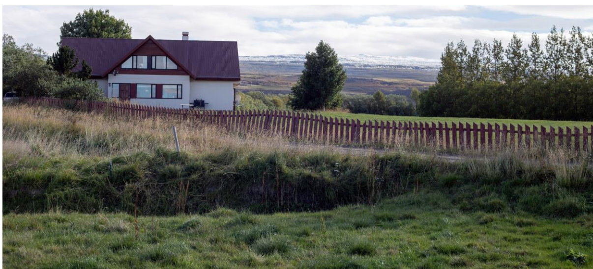
MYND 4.65 Horft í austur frá vegi við Gilsárteig II í átt að stöðvarhúsi sem er í hvarfi í um 1 km fjarlægð.
