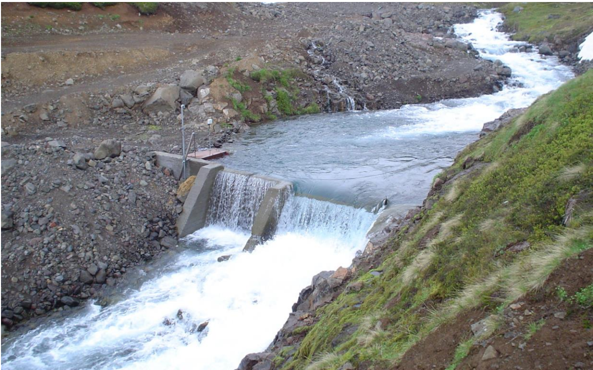
MYND 2.12 Lítið steyppt inntak í Kerahnjúkavirkjun á Norðurlandi. Útfærsla inntaksins verður aðlöguð að Lambadalsánum en verður sambærileg því sem má sjá á þessari mynd.
