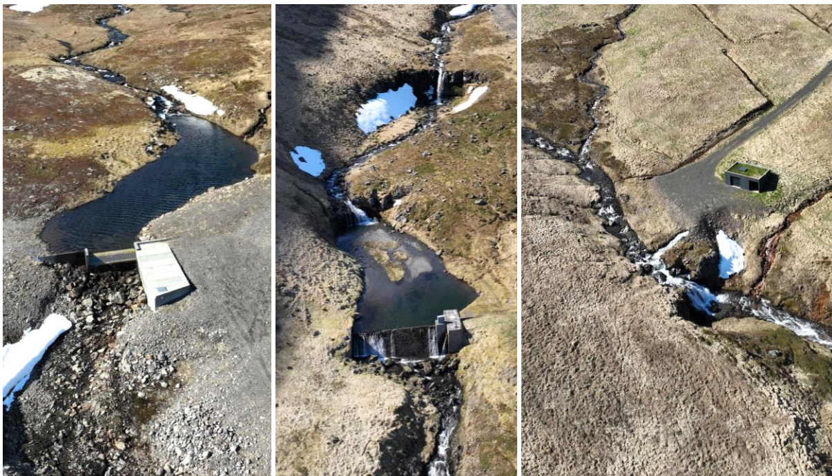
MYND 4.36 Úlfsárvirkjun á Vestfjörðum. Til vinstri sést inntakið þegar ekkert rennur um yfirfall og farvegur er þurr strax neðan stíflu. Fyrir miðju er rennsli við gamalt vatnsból um 1 km neðan inntaks, og til hægri sést hvar vatn kemur aftur út í farveg frá stöðvarhúsi um 2 km neðan inntaks. Farvegur er ekki þurr nema allra næst stíflu og við stöðvarhús er vatn bakka á milli.
