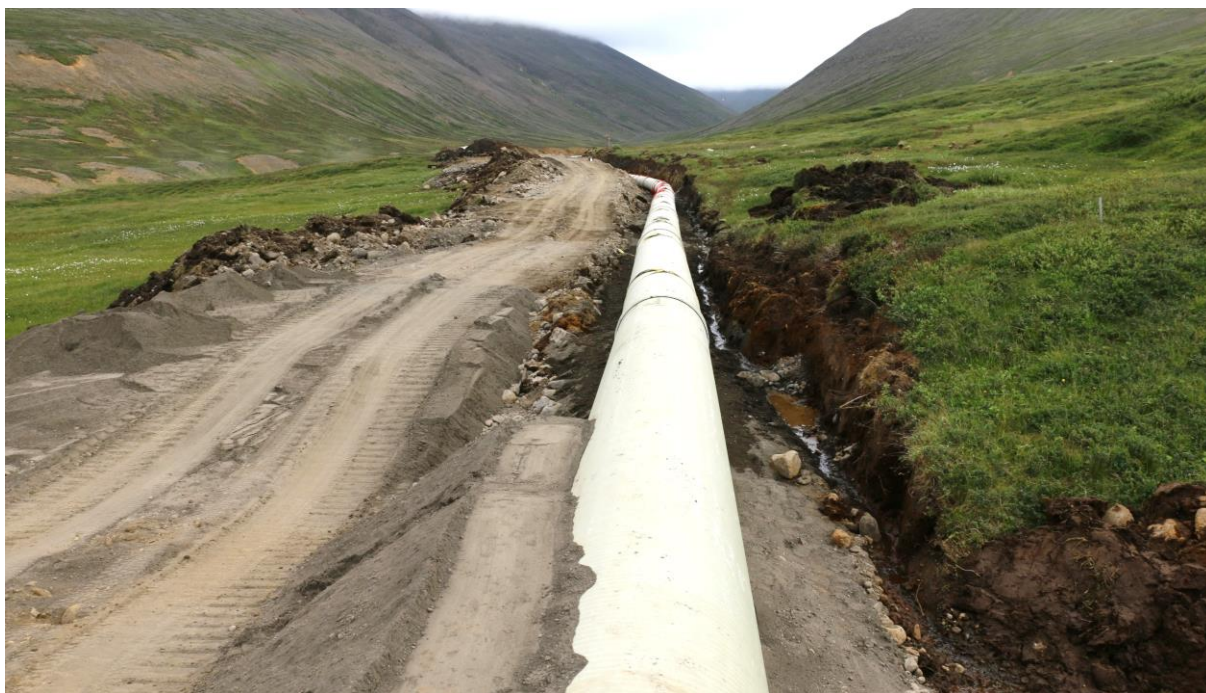
MYND 2.14 Mynd af lagningu aðrennslispípu Hólsvirkjunar á Norðurlandi. Gert er ráð fyrir sambærilegu verklagi við Gilsárvirkjun.
