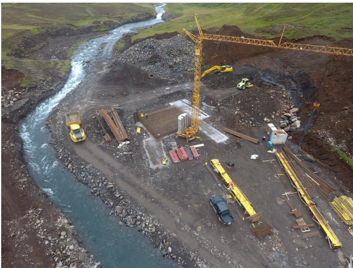
MYND 4.44 Á framkvæmdatíma eru ár settar í farveg til að halda þeim frá framkvæmdasvæði. Engin gruggmyndun verður nema rétt á meðan færslu stendur. Mynd frá Hólsvirkjun á framkvæmdatíma í ágúst 2019.
