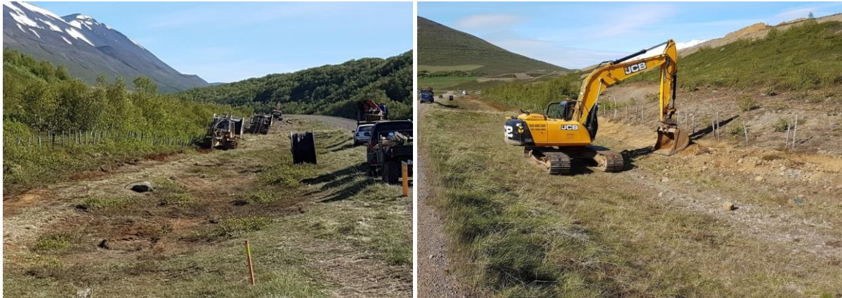
MYND 2.28 Myndir frá því þegar verið var að plægja 33 kV jarðstreng Hólvirkjunar meðfram Fnjóskadalsvegi. Á undan fara jarðýtur sem plægja strenginn niður í jörðina, og á eftir kemur grafa sem sér um frágang.
