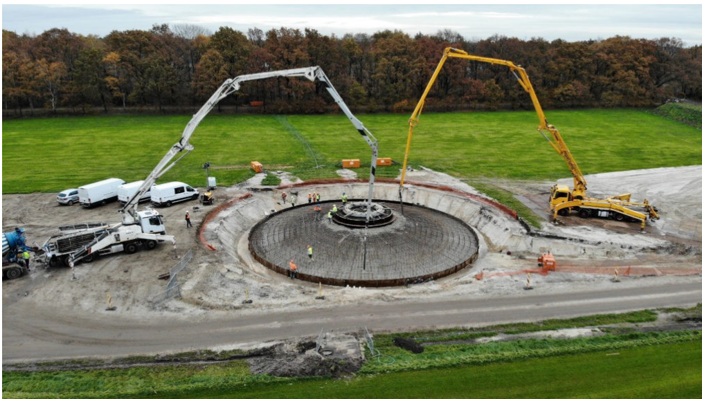
Mynd 19 Hefðbundinn steypur undirstöðupallur.
