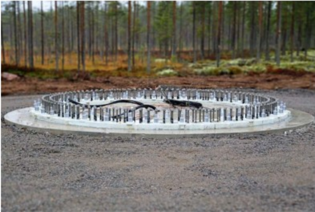
Mynd 18 Akkerisundirstaða í Saarenkyla vindorkugarðinum í Finnlandi.
