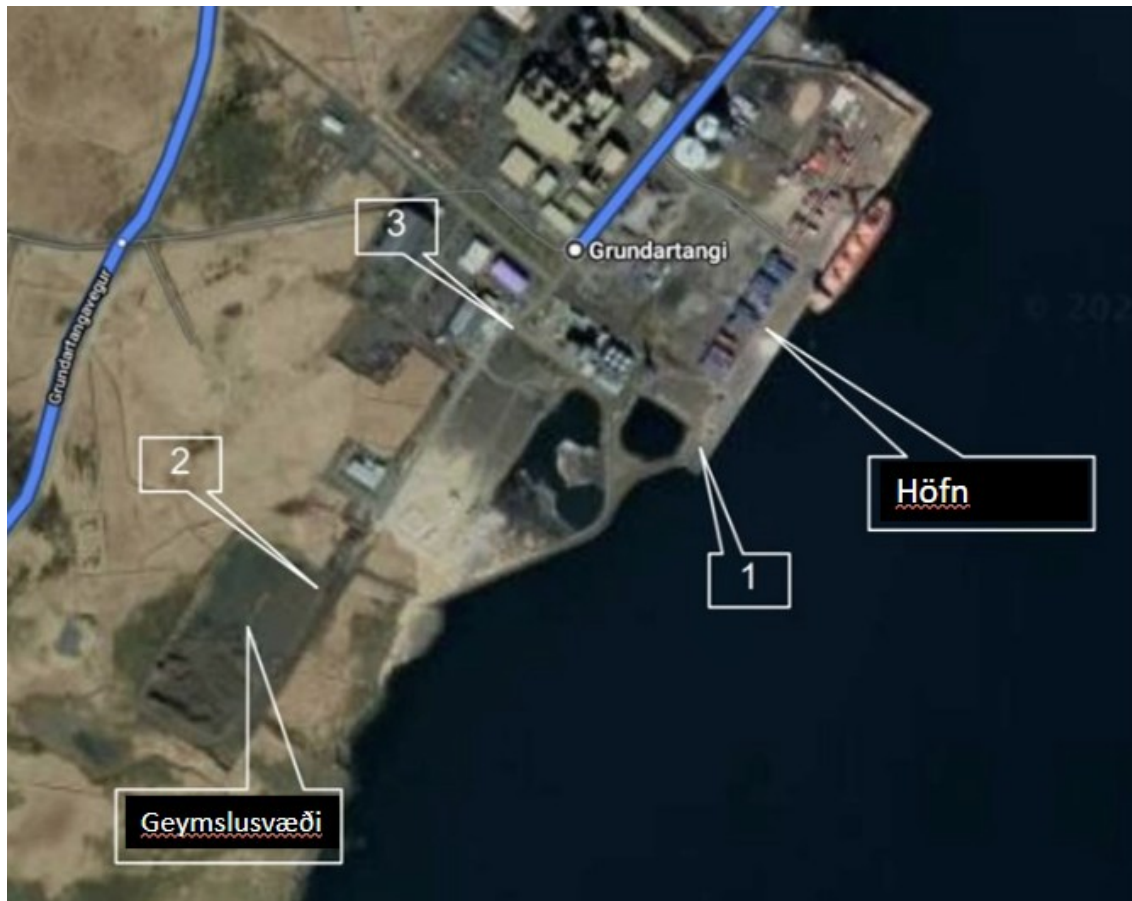
Mynd 16 Geymslusvæði fyrir búnað við Grundartangahöfn
