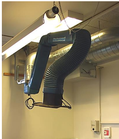
Mynd 1: Dæmi um færanlegt útsog.
