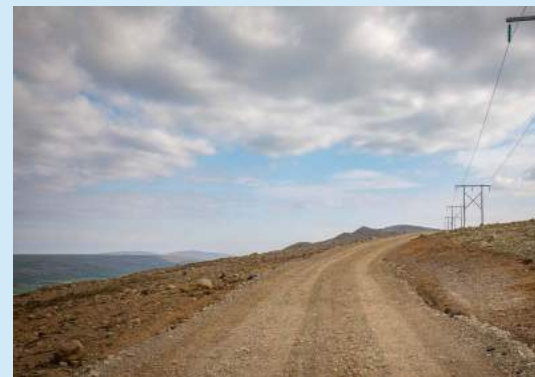
Dæmi 4. Nýleg línuslóð vegna Hólasandslínu 3
