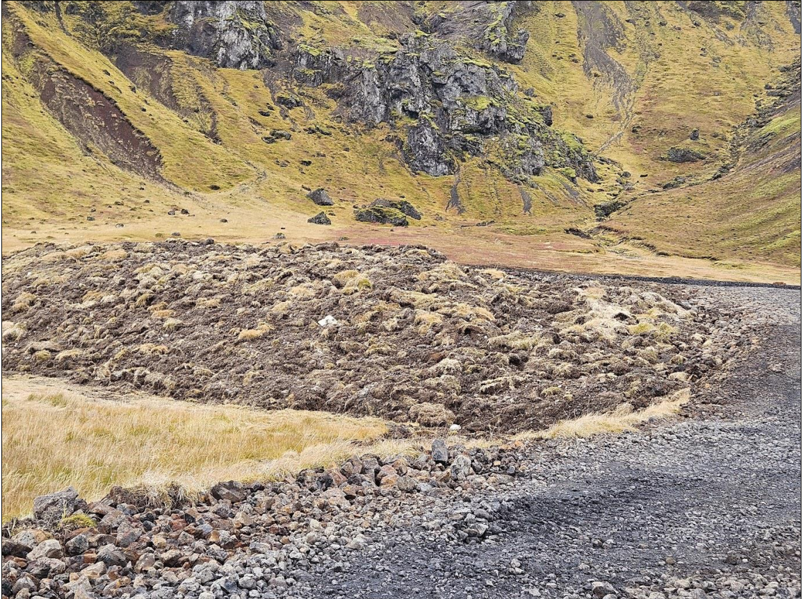
Mynd 5.10 Dæmi um frágang á borplani þar sem gróðurþekja hefur verið endurlögð í kanta. Með sama hætti verður gróðurþekja nýtt við frágang jarðvegsmána.
