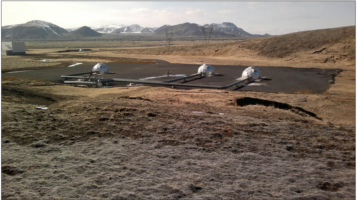
Mynd 5.4 Borteigur á Hellisheiði með þremur borholum.
