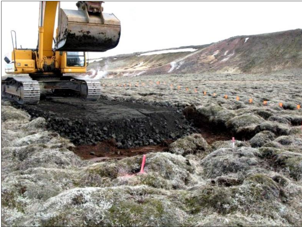
Mynd 5.6 Vegslóði sem verið er að leggja, vegslóðinn er grafinn svo hann liggi í sömu hæð og landið umhverfis hann.
