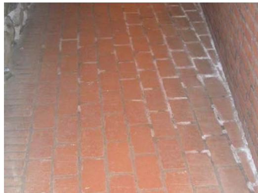
Mynd 66: Hvítir flekkir af völdum myglusvepps Malbranchea anamorphic . Mynd 67: Saltútfellingar, hvítleit skán í fúgum á milli múrsteina.
