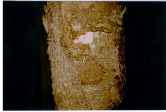
Mynd 42: Dæmi um bót sem límd hefur verið yfir göt á burðarlagi. Mynd 43: Göt á jaðri eftir blásaum sem sýna að striginn hefur verið strekktur nokkrum sinnum í gegnum tíðina.
