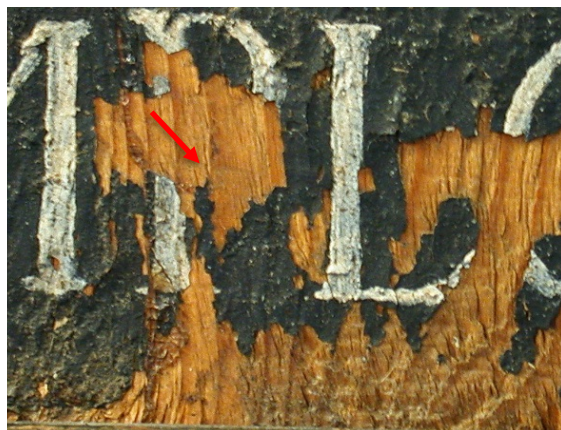
Mynd 28: Vandaður frágangur: yfirborð fjarlarinnar er slétt. För eftir verkfæri sjást hægra megin.
