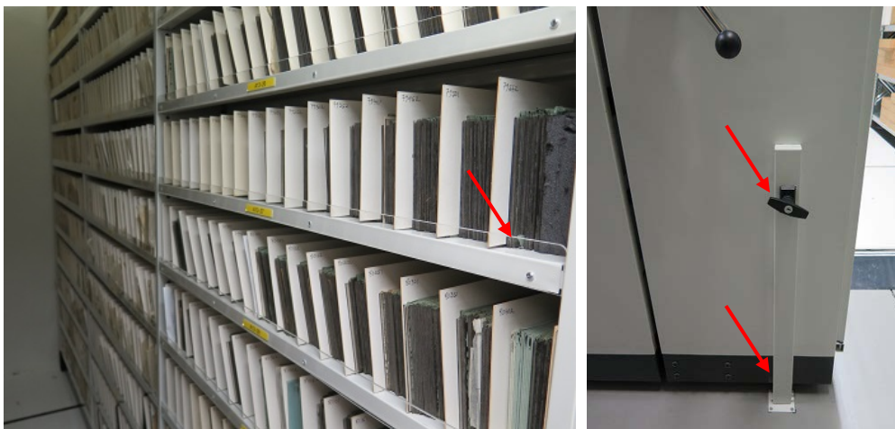
Mynd 55: Dæmi um hilla með kanti úr gegnsæju hörðu plasti. Mynd 56: Stopparar á þéttiskáp.
