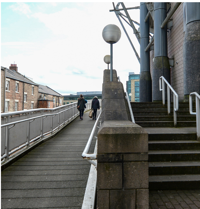
Figura 11. Rampa d'accesso situata nell'angolo Sud -Est
