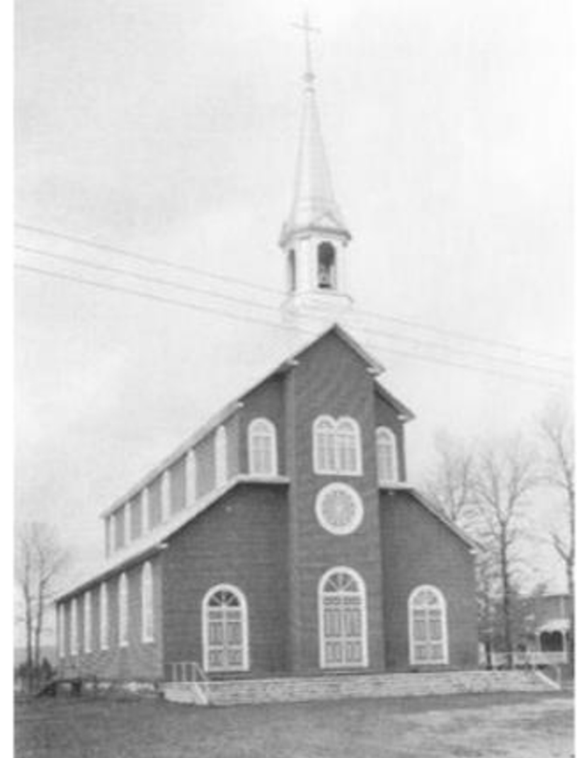
Église Sainte-Christine-d'Auvergne, date photo inconnue Recouvrement (non d'origine) de papier brique Source : Répertoire patrimoine MRC Portneuf, fournie par la Corporation dans la demande de projet
