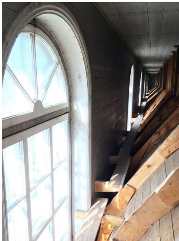
Dans l'entretoit de la voûte de l'église. Source : Écobâtiment
