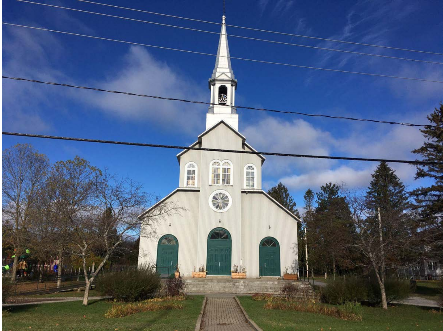
Parvis de l'église. Source : Écobâtiment
