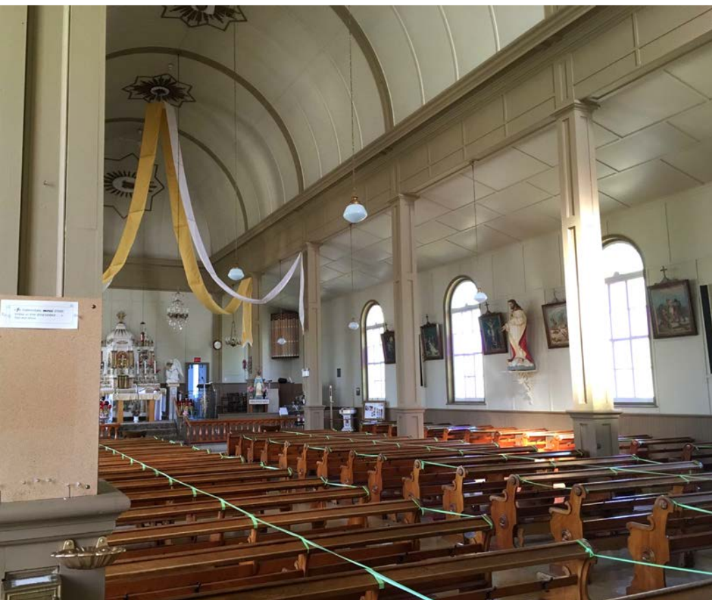
On voit que la voûte est relativement sombre et qu'elle bloque les fenêtres à ce niveau. Source : Écobâtiment
