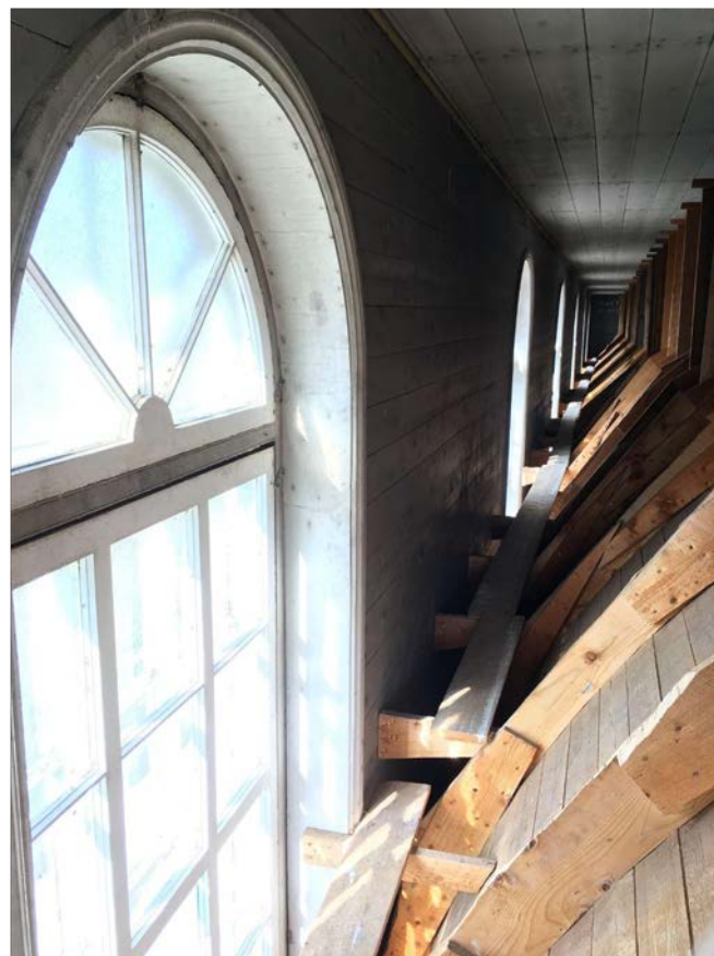
Ouvertures cachées par la voûte de l'église. Source : Écobâtiment
