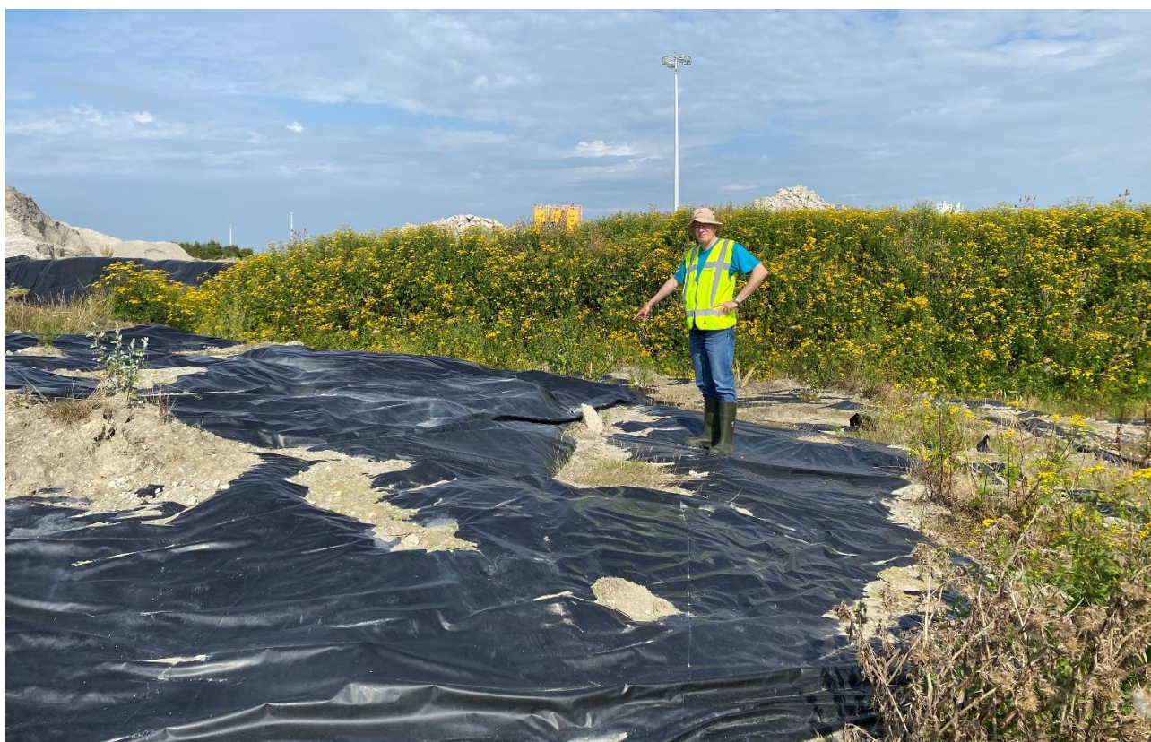
Vrijdag 2 augustus 2024, TTOP 1, op de oosthoek, bovenkant van de opslag zagen we een beschadiging.
