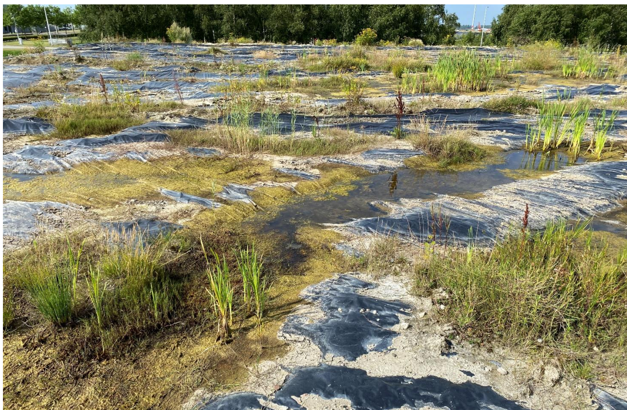
De geheel afgedekte grondopslag van met PFAS (PFOS) verontreinigde grond op de TTOP 1 , op vrijdag 2 augustus 2024. (De TTOP 1 wordt slechts gedeeltelijk gebruikt voor grondopslag. Namelijk als circulaire HUB)
