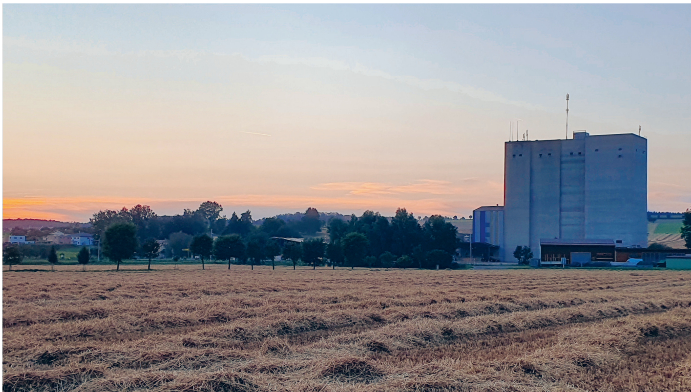
Couché de soleil sur le centre collecteur de Alle.
