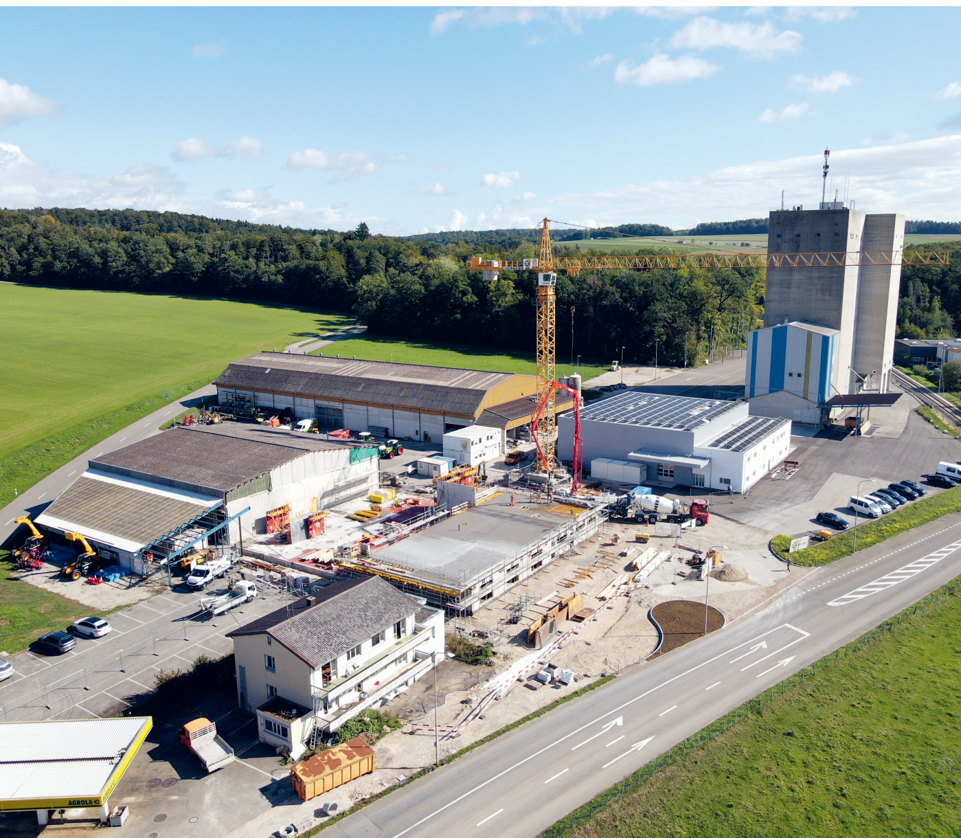
Chantier Centre Ajoie.
