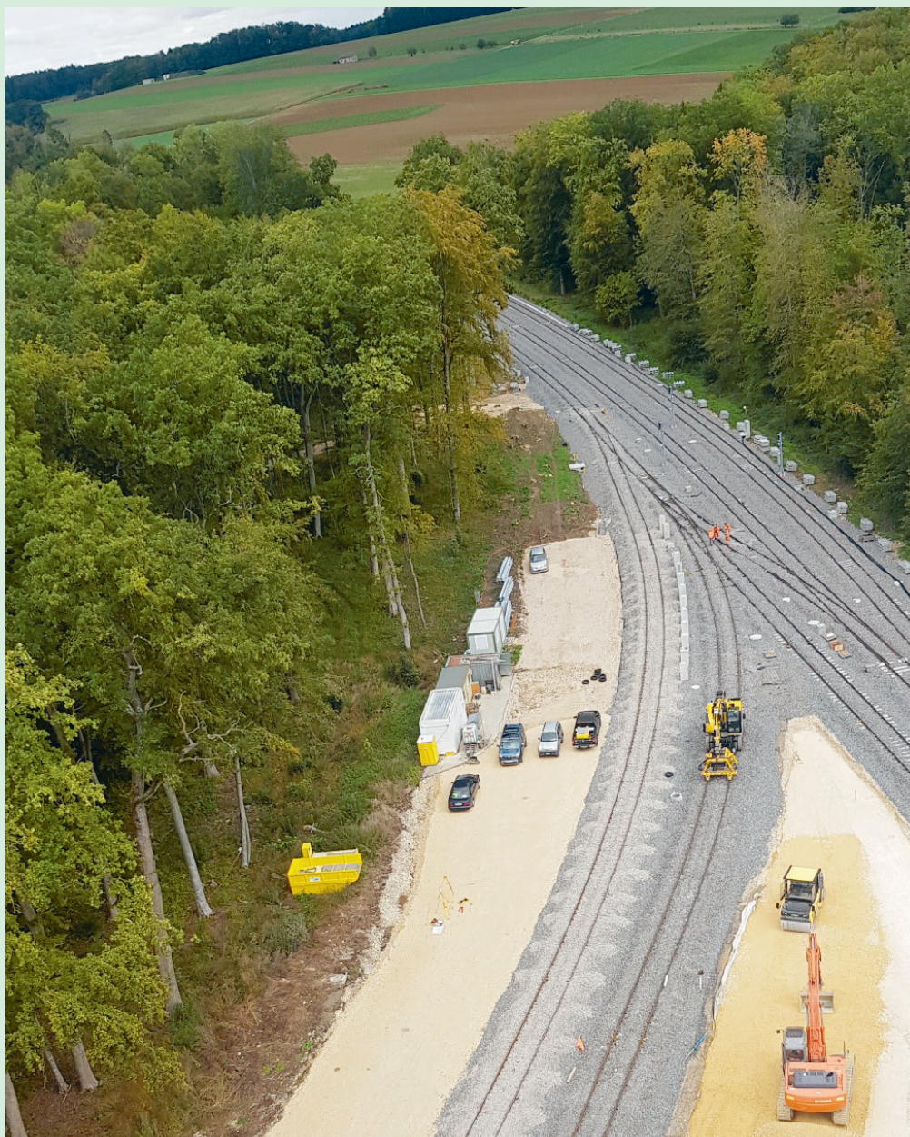
Pose des rails - voie de raccordement Alle.
