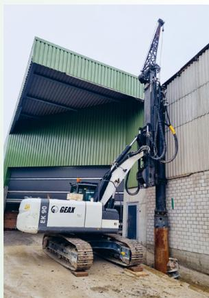
Am 18. November 2024 erfolgte der Baustart für die 16 neuen Verladzellen bei der Trocknungsanlage. Bevor mit dem Pfählen angefangen werden konnte, musste das bestehende Vordach demontiert werden. Nach dem Pfählen begann der Baumeister mit dem Bau vom Betonriegel gebäudeseitig. Die Platzierung der Ankerplatten für die Abstützung der Silozel-
