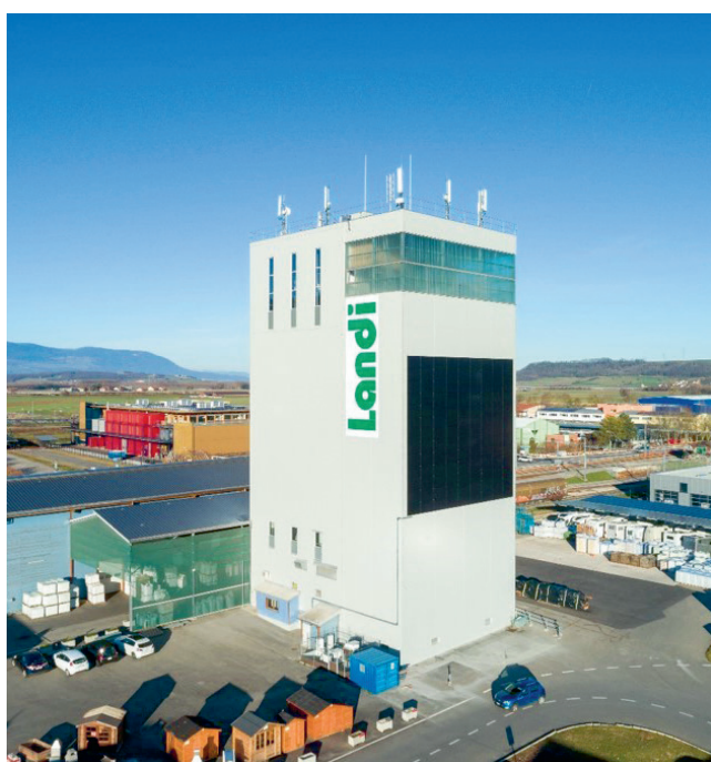
Les silos de Orbe et Eysins après assainissement des façades. A Orbe, des panneaux photovoltaïques ont été installés
