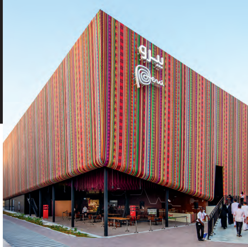
بيرو الموقع: منطقة التنقل الهندسة المعمارية: "هابيتارني"
