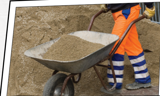
DÉPLACER UNE CHARGE À L'AIDE D'UNE BROUETTE, LEVIER DU DEUXIÈME GENRE
