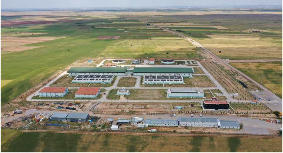
Şekil 3.3.1.2. Konya Mavi Tünel İçmesuyu Arıtma Tesisi
