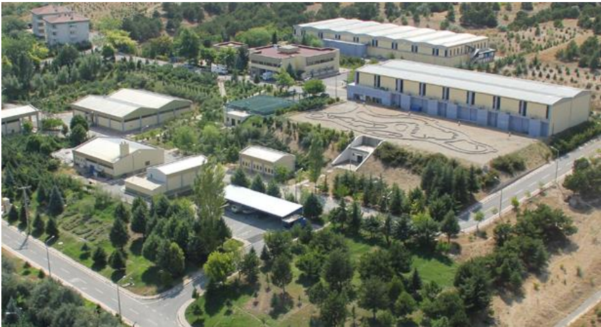
Şekil 3.3.1.1. Konya (Akyokuş) İçmesuyu Arıtma Tesisi
