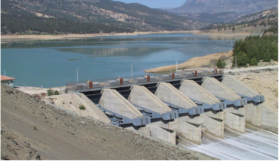
Şekil 3.1.2.2. Gezende Barajı ve HES
