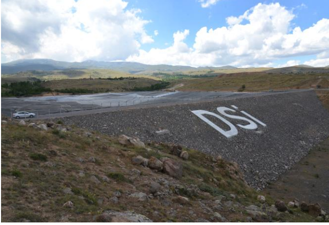
Şekil 3.2.9.2. Niğde Yeşilburç Barajı ve Derivasyon Tesisleri
