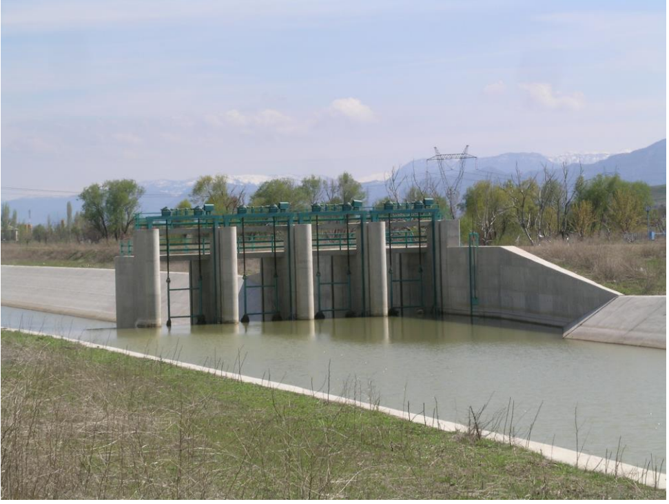
Şekil 3.2.1.18. Beyşehir Suğla Apa (BSA) Kanalı
