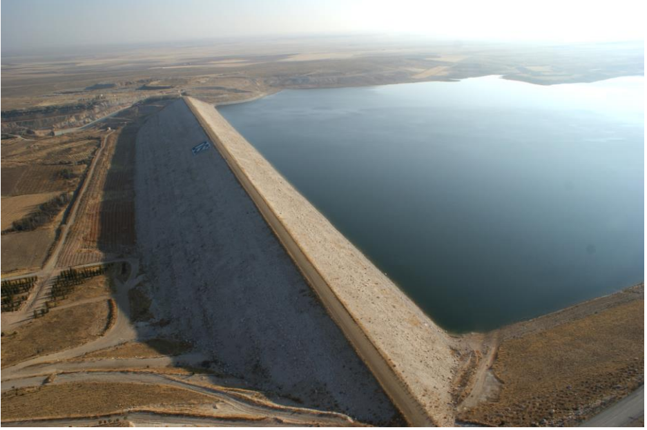
Şekil 3.2.6.1. Karaman İbrala Barajı
