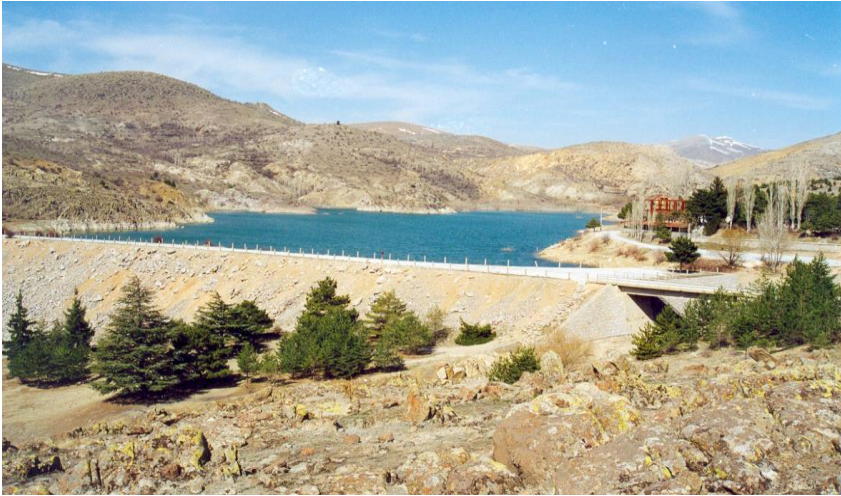
Şekil 3.2.1.9. Konya Sille Himmet Ölçmen Barajı
