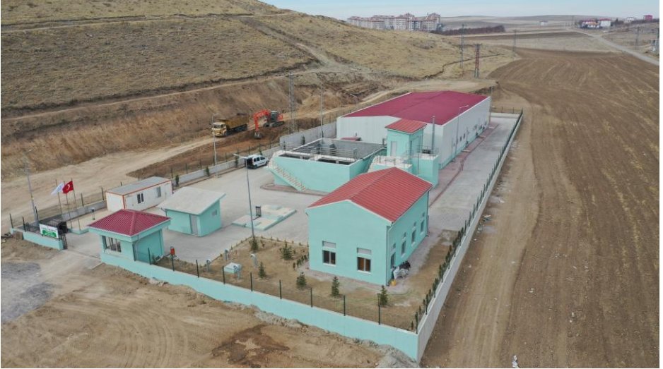
Şekil 3.3.4.1 Niğde Ulukışla İçmesuyu Tesisleri
