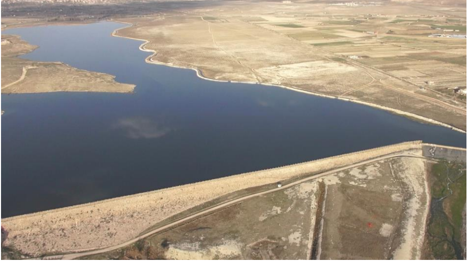
Şekil 3.2.8.1. Niğde Akkaya Barajı
