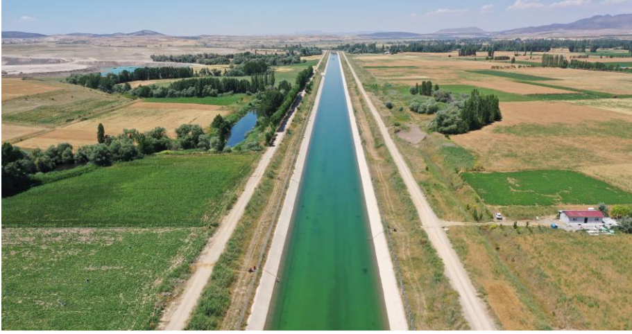
Şekil 3.2.1.17. Beyşehir – Suğla – Apa (BSA) Kanalı
