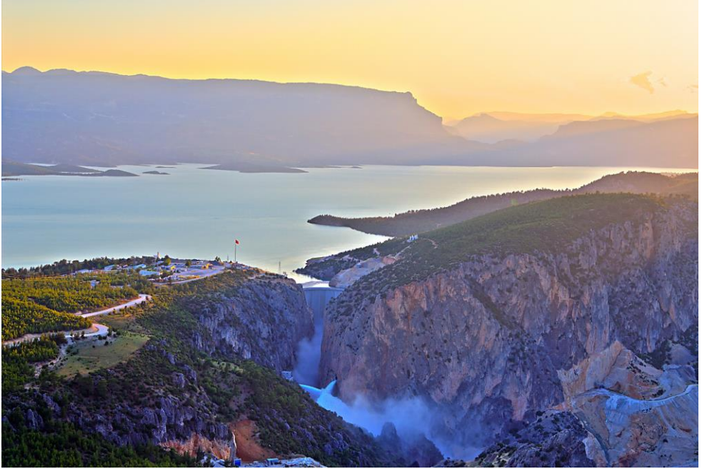
Şekil 3.1.1.4. Karaman Ermenek Barajı ve HES
