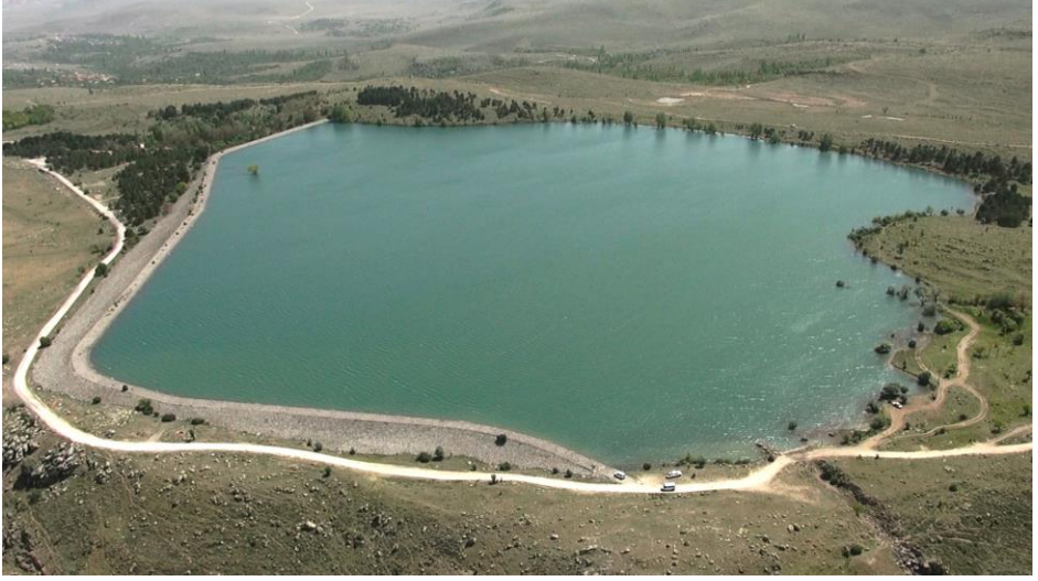
Şekil 3.2.9.1. Niğde Gebere Barajı
