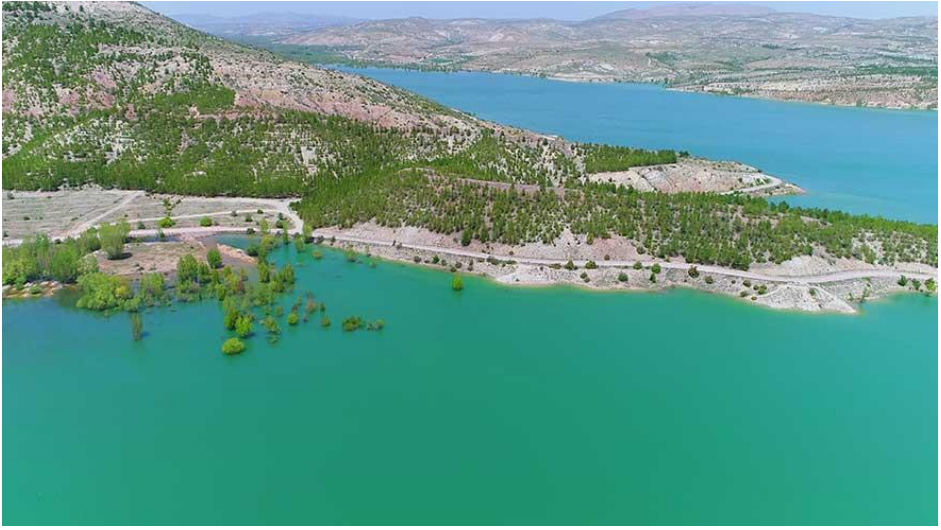
Şekil 3.2.1.5. Konya Altınapa Barajı
