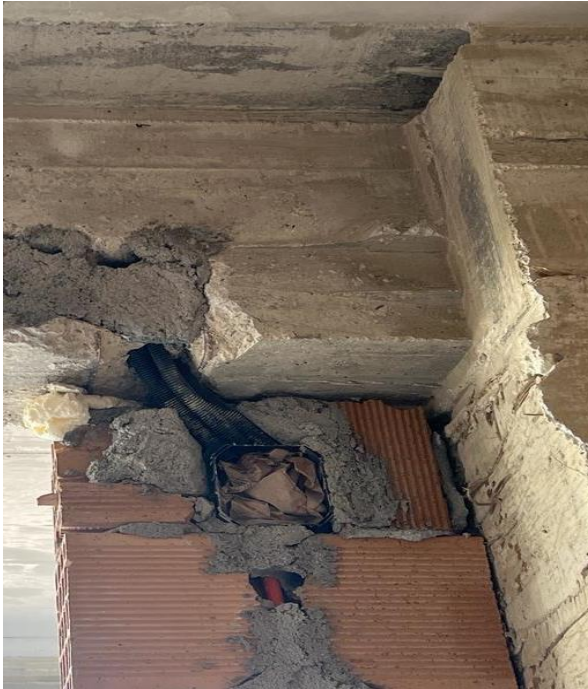
Resim 3.24. Bina Taşıyıcı Sistemleri İçinden Boru ve Benzeri Malzeme Geçirerek Taşıma Kapasitesini Azaltmak ve Bina Emniyetini Statik/Dinamik Yükler Altında Riske Sokan Uygulamaların Görünüşü
