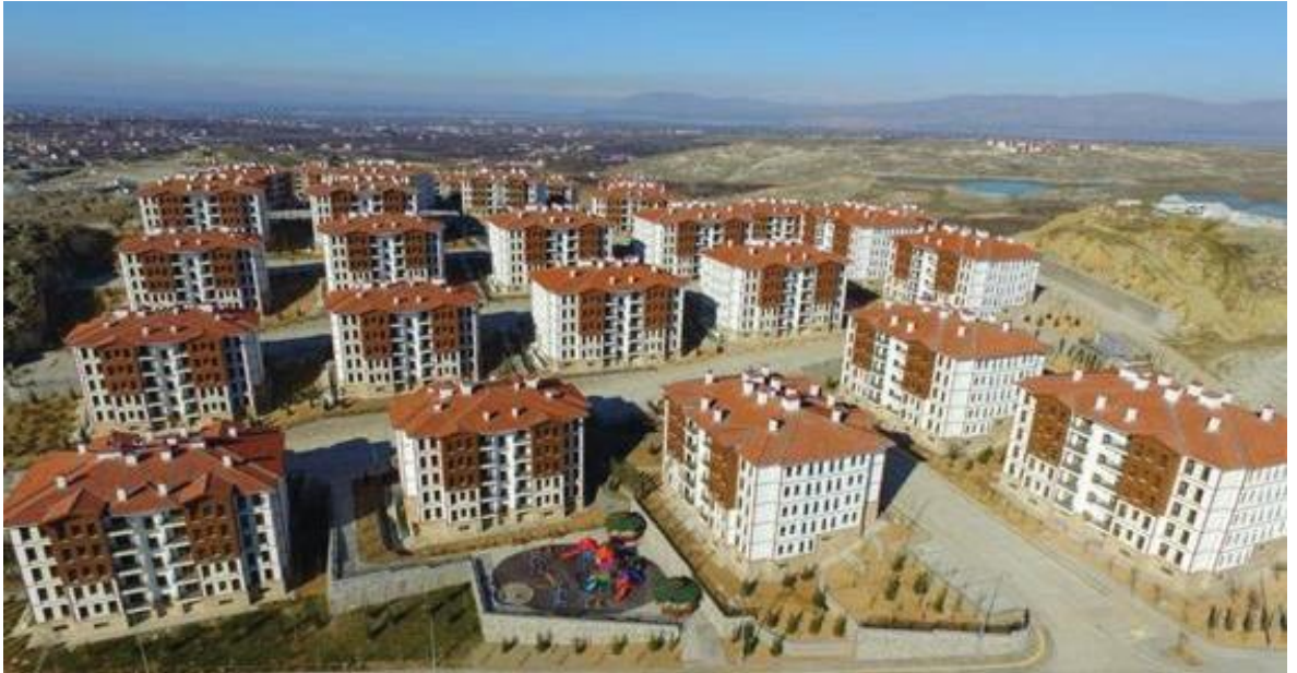
Resim 3.31. Tünel Kalıp Sistemiyle İnşa Edilen TOKİ Evleri, Battalgazi İlçesi, Orduzu Mahallesi, Gelincik tepesi, Malatya
