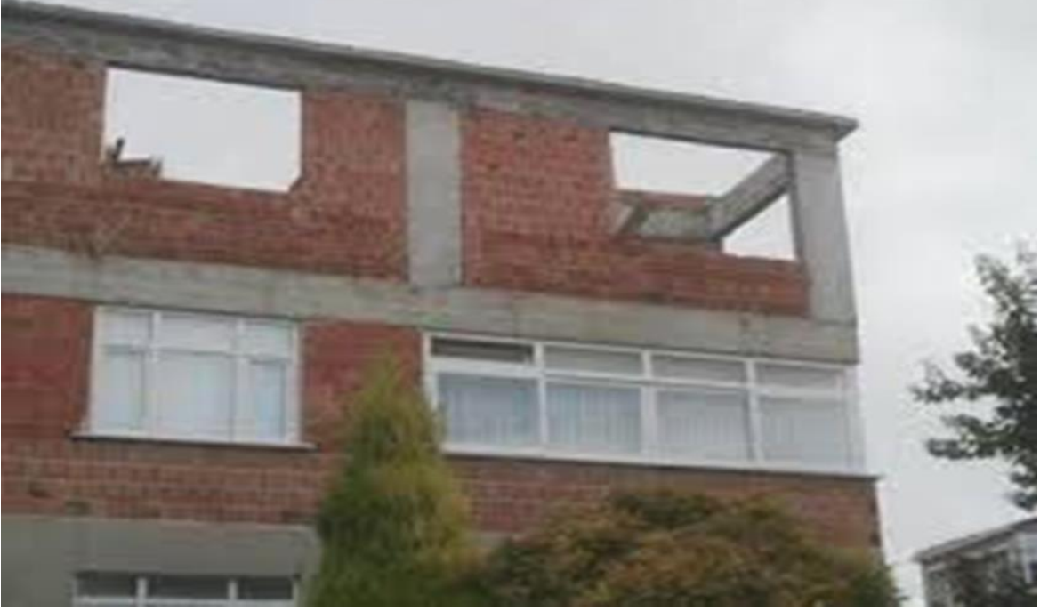
Resim 3.19. Düşey Düzensizlik, Kolon Kirişe Oturtuldu. Kolonlarda Süreklilik Yok Kaynak: Yapı İşleri Genel Müdürlüğü'nün TBMM Deprem Komisyonuna 21.03.2023 tarihinde yaptığı sunum.
