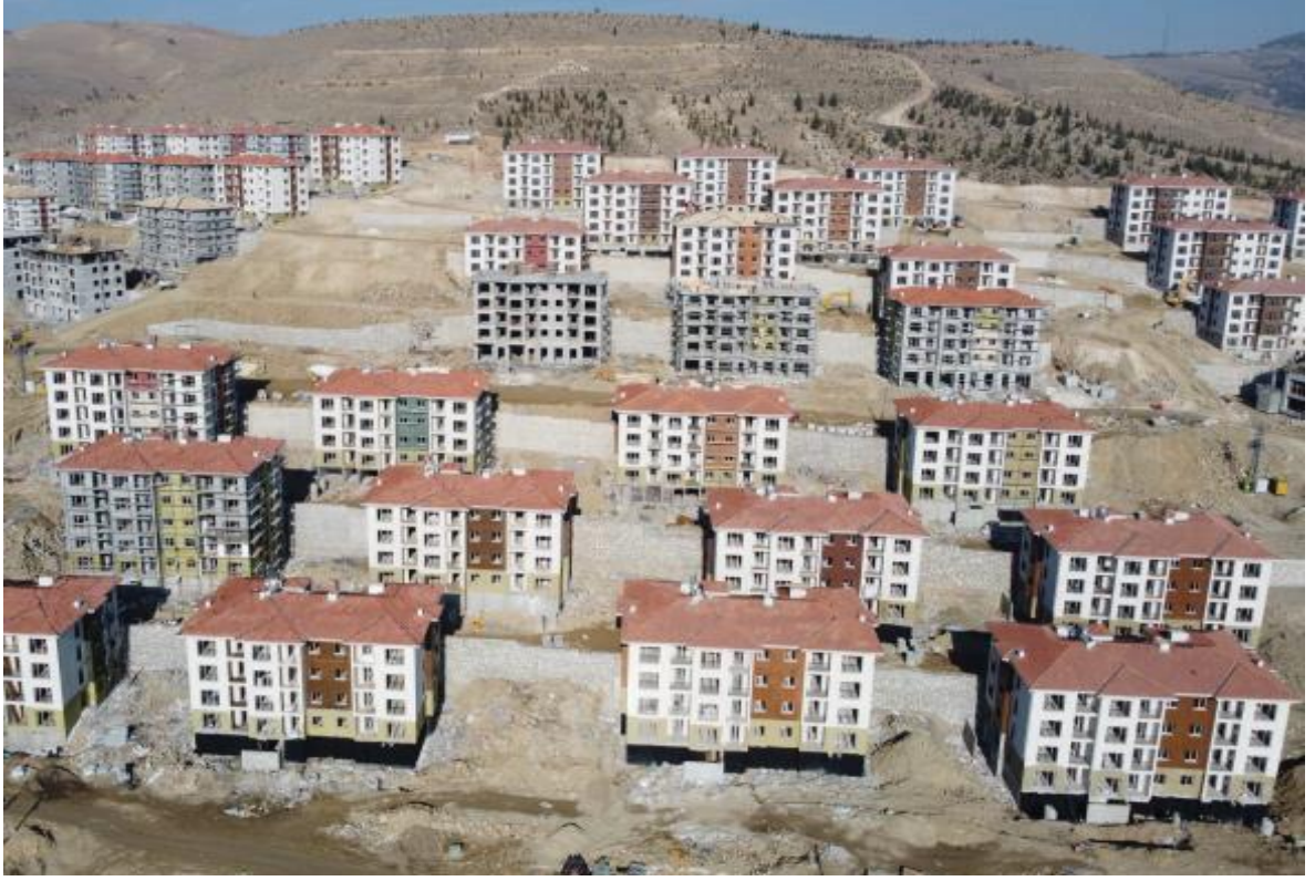
Resim 3.30. Tünel Kalıp Sistemiyle İnşa Edilen TOKİ Evleri, Zafran Mahallesi, Elazığ
