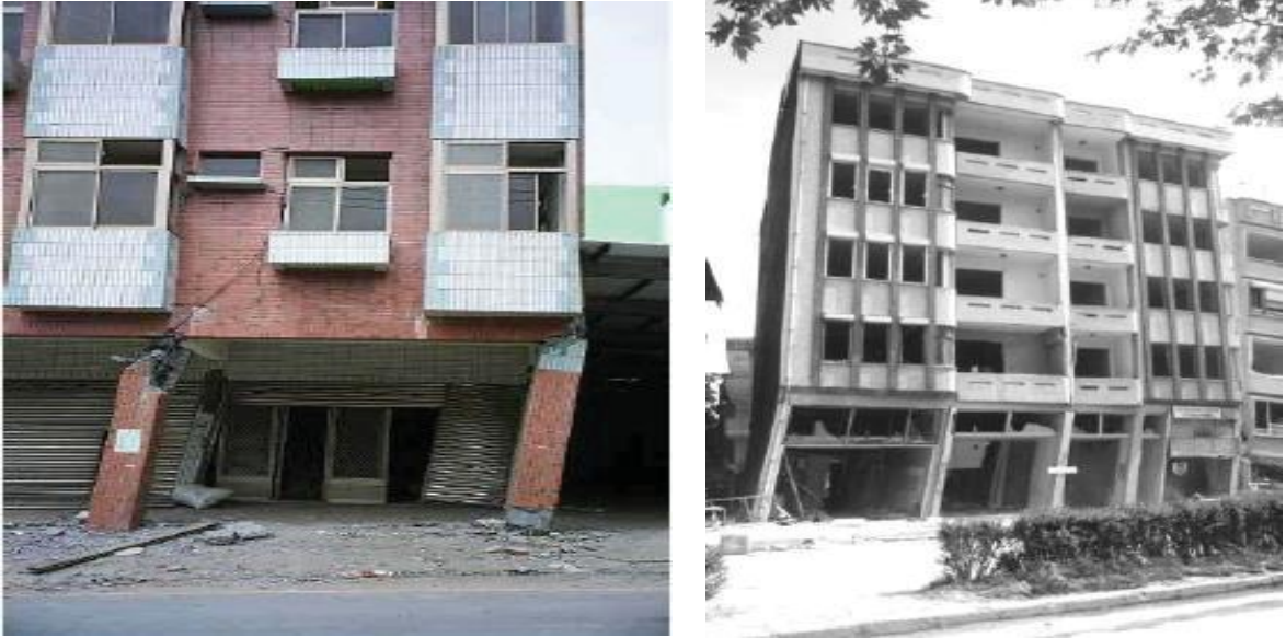
Resim 3.16. Zayıf Kat /Yumuşak Kat Örnekleri
