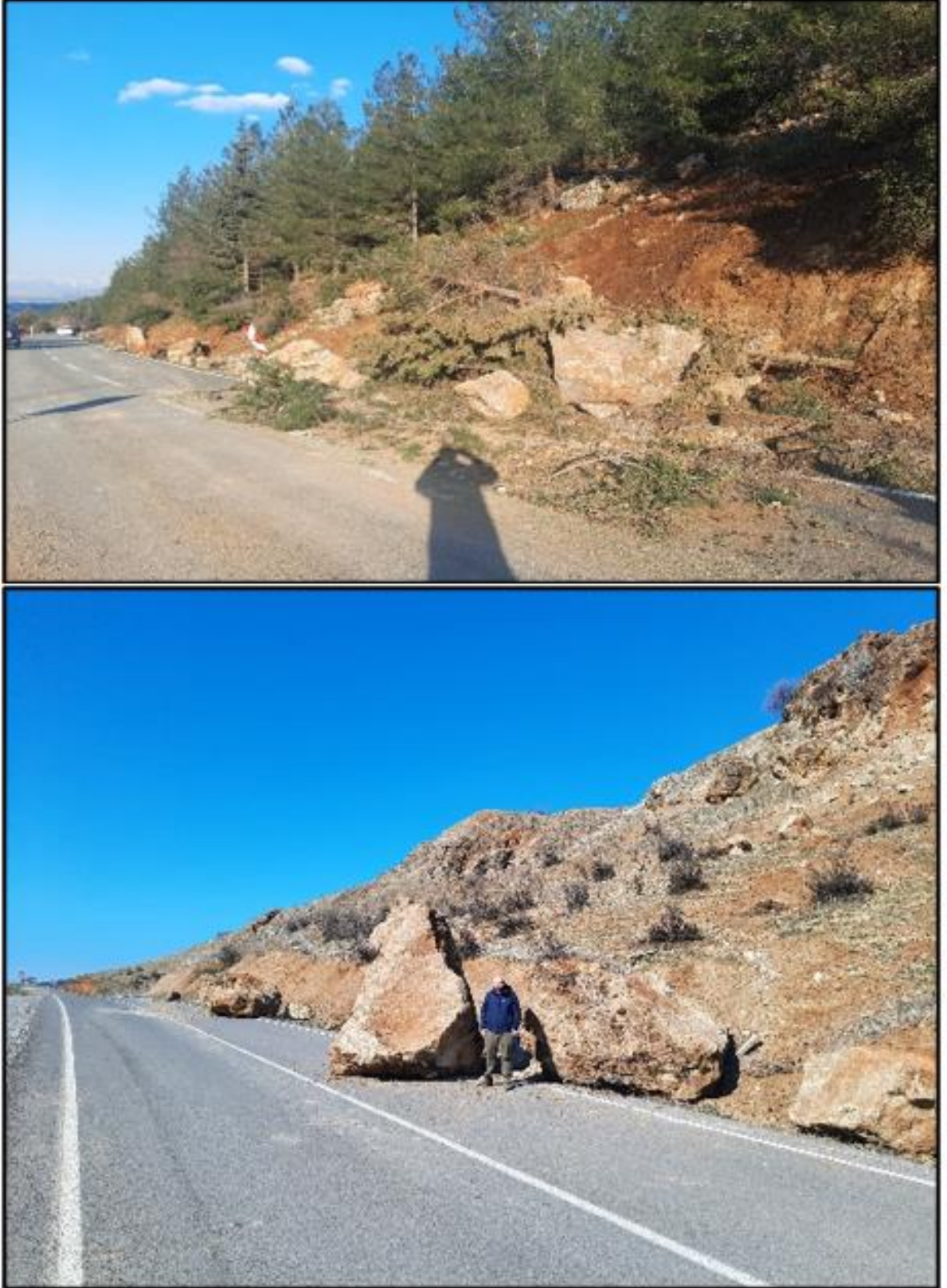
Resim 3.3. Kahramanmaraş İli Türkoğlu İlçesi Yeşilyurt Köyü Yolu Meydana Gelen Kaya Düşmesi ve Kahramanmaraş İli Dulkadiroğlu İlçesinde Karayolu Üzerinde Meydana Gelen Kaya Düşmesi
