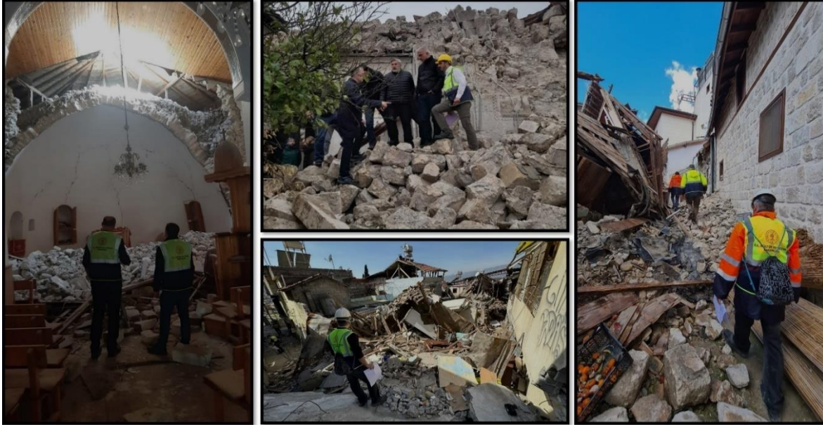
Resim 1.29. Kültür Varlıkları ve Müzeler Genel Müdürlüğüne Yürütülen Hasar Tespit Çalışmaları
