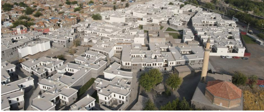
Resim 4.30. Diyarbakır Suriçi Dönüşümü Faaliyetleri 491
