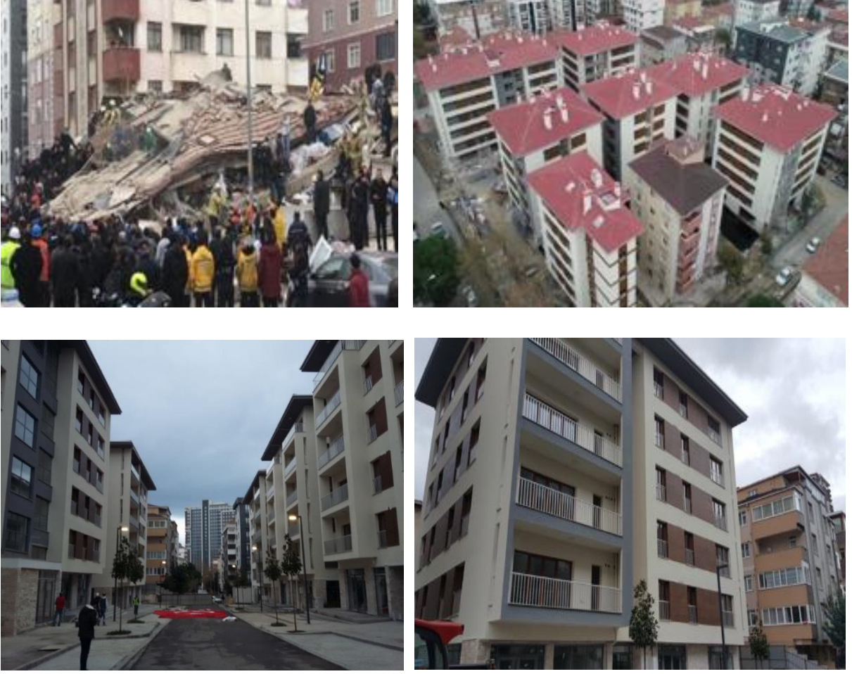
Resim 4.42. İstanbul İli, Kartal İlçesi, Orhantepe Mahallesi'nde Kendiliğinden Göçmüş Olan Yeşilyurt Apartmanı / Kartal Kentsel Dönüşüm Projesi Çerçevesinde Üretilen Güvenli Konutlar 514
