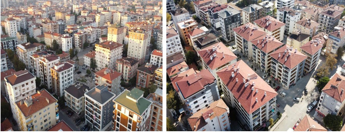
Resim 4.31. İstanbul ili, Kartal ilçesi, Orhantepe Mahallesi Kentsel Dönüşüm Projesi 494
