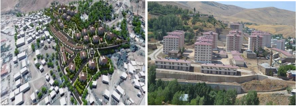
Resim 4.3. Muş İli, Merkez İlçesi, Kale Mahallesi Kentsel Dönüşüm Gelişim Proje Alanı 441
