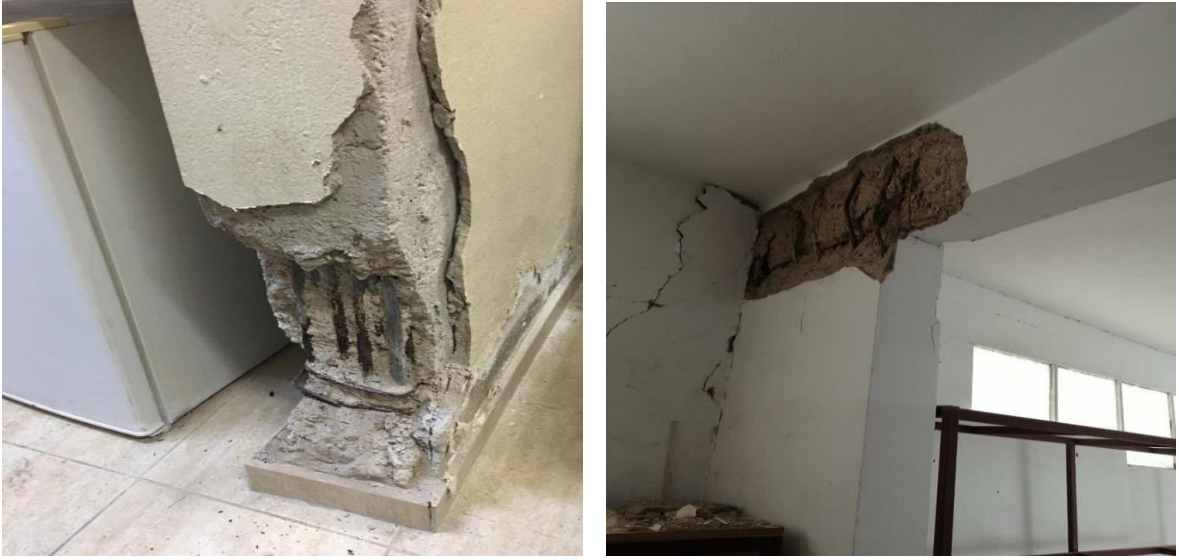
Resim 3.23. Kolon Alt Başlığında ve Kolon-Kiriş Birleşim Bölgesinde Yetersiz Etriye
