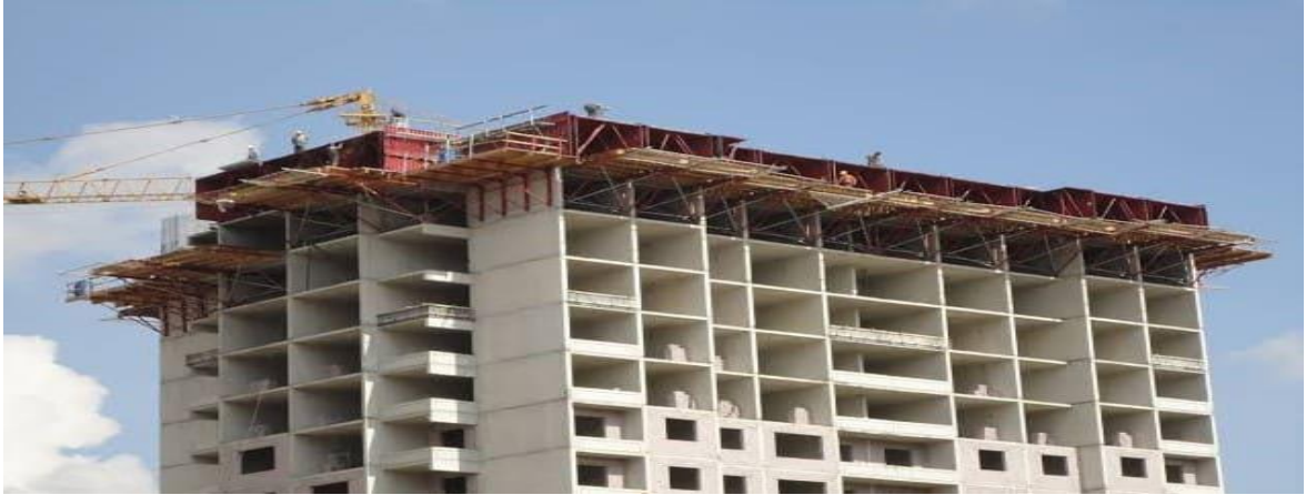
Resim 3.29. Tünel Kalıp Sistemi İle İnşa Edilen Bir Binanın Görünüşü
