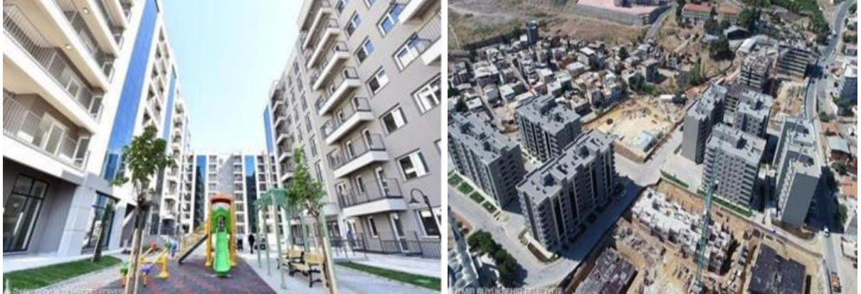
Resim 4.2. İzmir İli Karabağlar İlçesi, Uzundere Mahallesi Kentsel Dönüşüm ve Gelişim Proje Alanı 439
