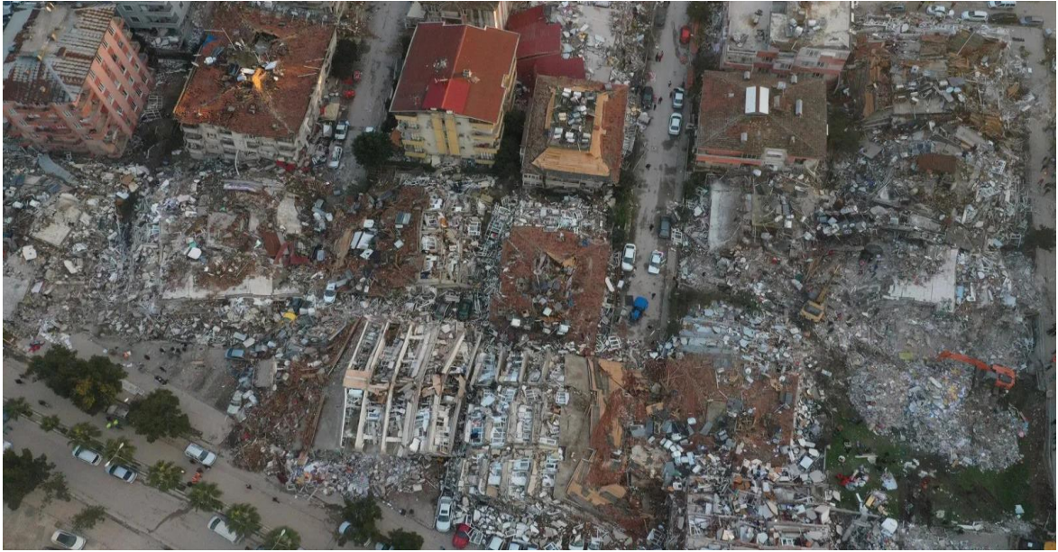
Resim 3.13. Kahramanmaraş Merkezinde Toptan Göçen Binaların Görünüşü
