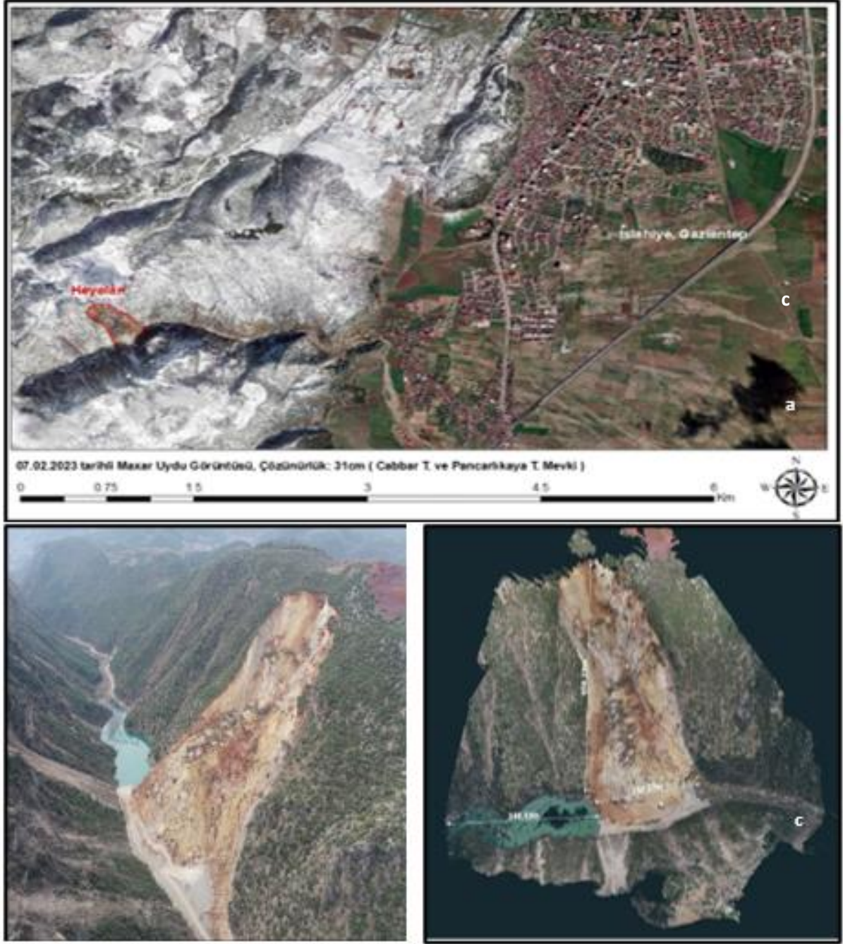
Resim 3.4. 6 Şubat 2023 Kahramanmaraş Depreminden Sonra Gaziantep İli İslahiye İlçe Sınırları İçerisinde Meydana Gelen Heyelanın Uydu Görüntüsü ve İnsansız Hava Aracı (Drone) İle Elde Edilen Görüntü İle Heyelan Boyutlarının Belirlenmesi
