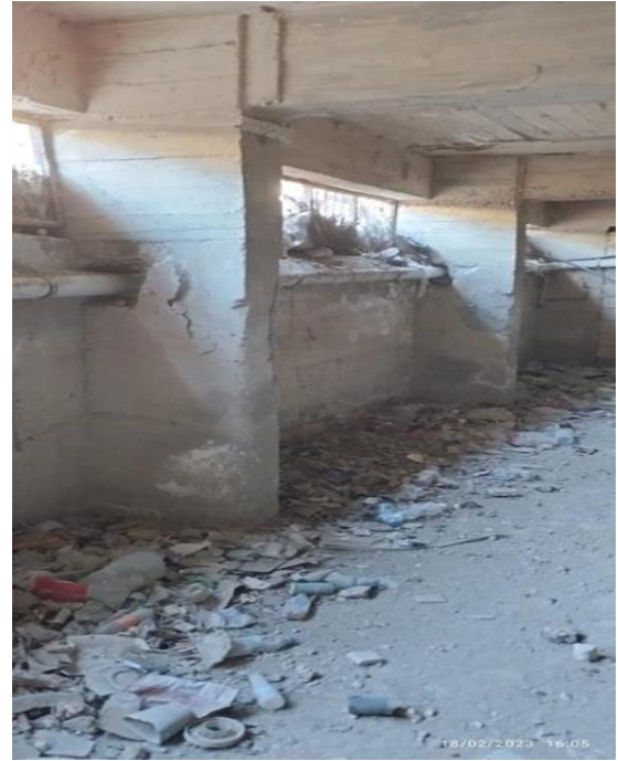
Resim 3.24. Bina Taşıyıcı Sistemleri İçinden Boru ve Benzeri Malzeme Geçirerek Taşıma Kapasitesini Azaltmak ve Bina Emniyetini Statik/Dinamik Yükler Altında Riske Sokan Uygulamaların Görünüşü
