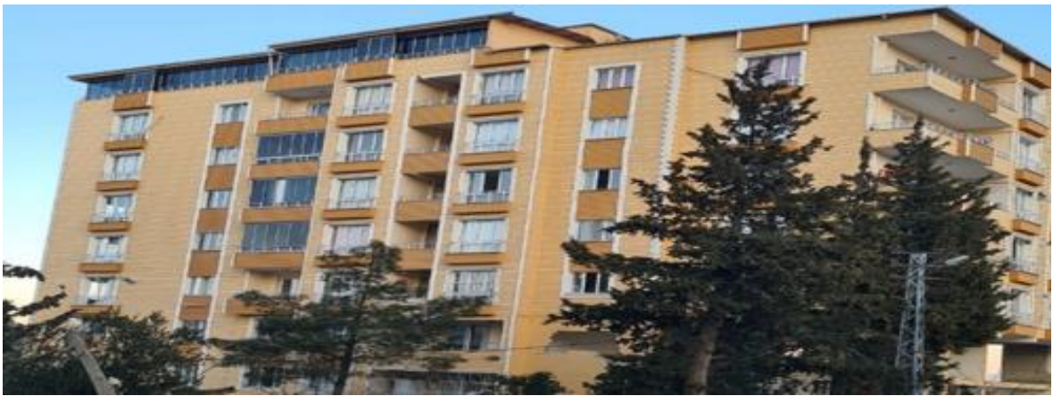
Resim 3.25. Deprem Sonrası Hasar Görmeyen Örnek Bir Binanın Görünüşü, Pazarcık/ Kahramanmaraş
