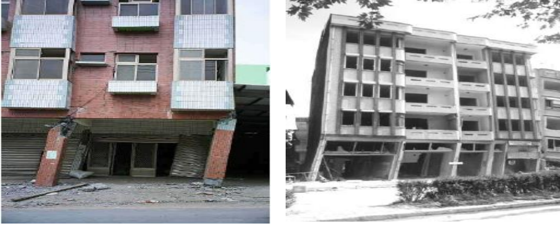
Resim 4.43. Zayıf / Yumuşak Kat Örnekleri 533
