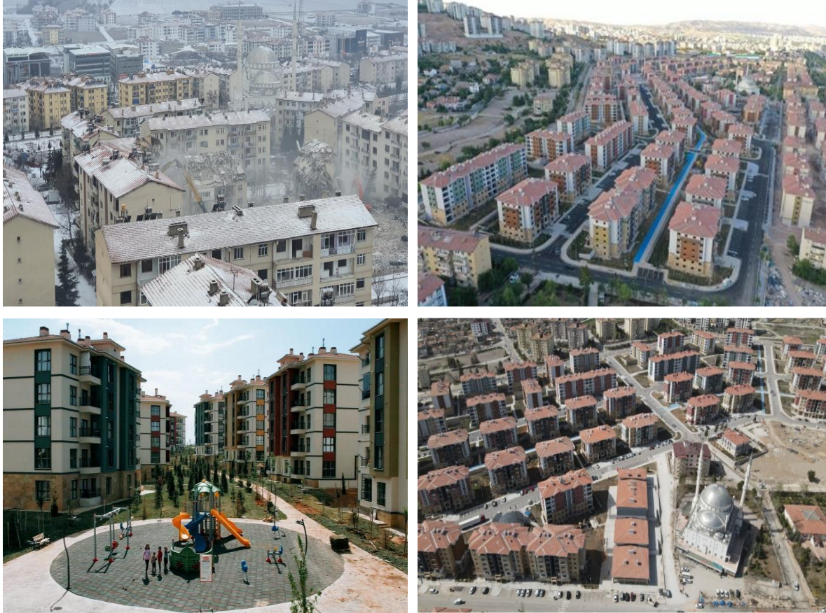
Resim 4.8. Elazığ Merkez Deprem Konutları-Öncesi ve Sonrası 466
